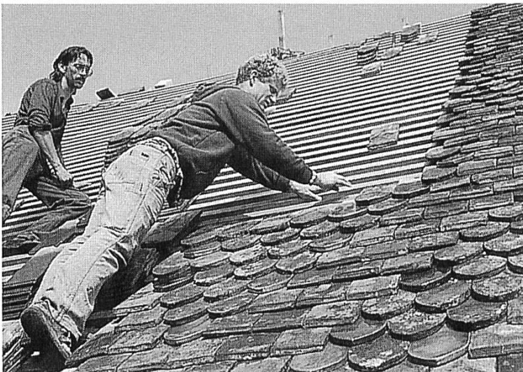
Abb. 2 Die Dachdecker beim Legen des Rautenmusters aus alten und neuen Ziegeln auf dem Dach der Niklauskapelle 1989.
