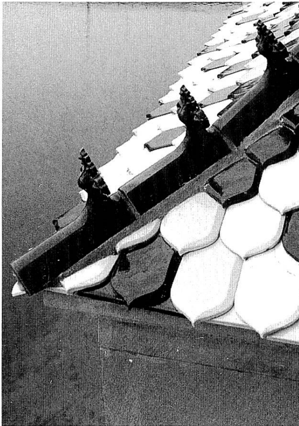
Abb. 17 Gratziegel auf Rhein- erker des Klosters St. Georgen in Stein am Rhein, 16./20. Jh.
