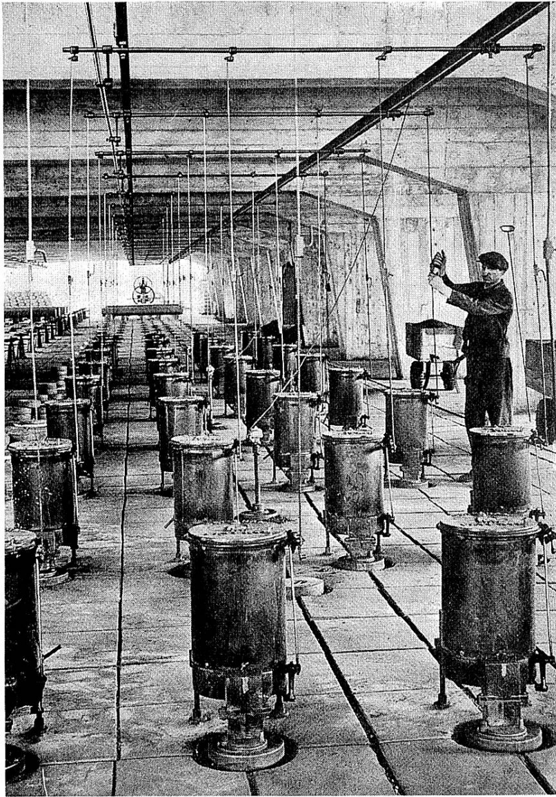
Abb. 43 Schürapparate auf Ringofen (A-87).
