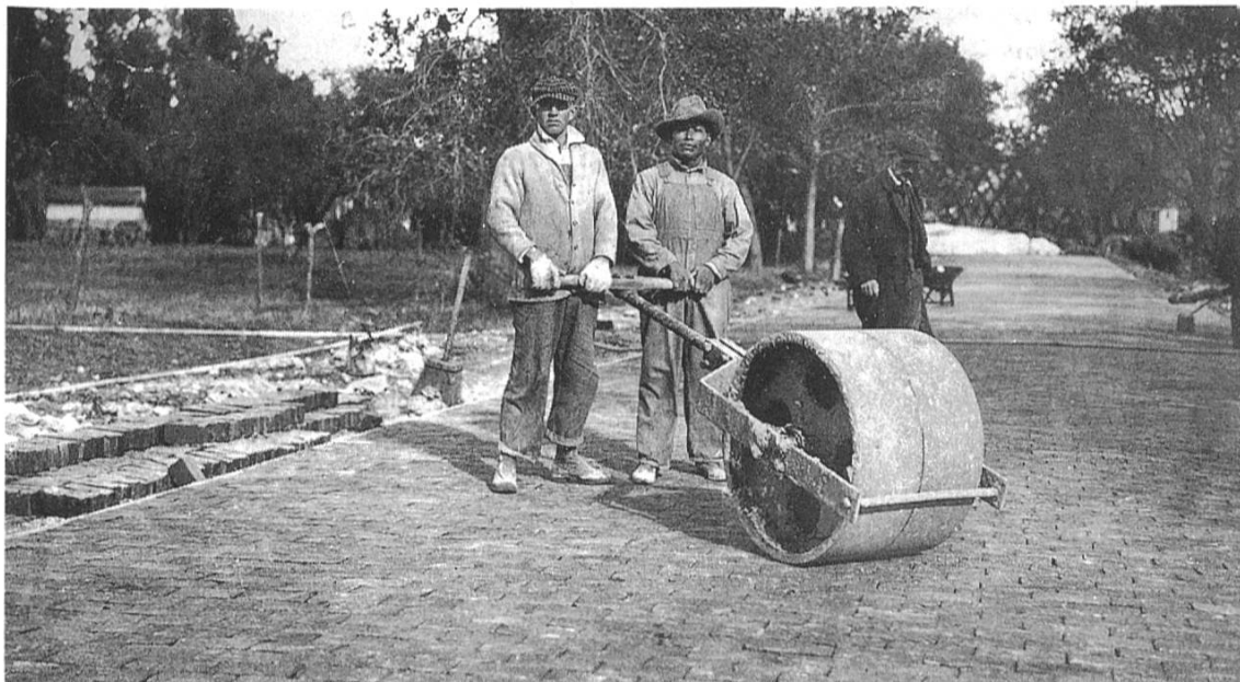
Abb. 6 Die Walze sorgt für eine tadellose Oberfläche.
