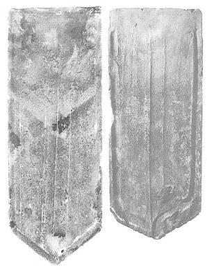
die Ziegelrückseite mit dem Streichholz flach abziehen und aus dem überstehenden Lehm die Nase formen. Bevor der Ziegel auf das Trockenbrettchen gekippt wurde, strich man mit dem Finger Jahrzahlen und Zeichnungen ein. Anschliessend wurde der auf das Brettchen gestürzte Ziegel mit Finger-, Rand- und Kopfstrich versehen. Nach dem Trocknen und Brennen waren die eingestrichenen Darstellungen auf der Rückseite noch genau so deutlich zu lesen wie auf der Vorlage.
