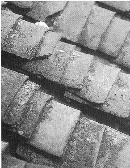
Abb. 6 Die Ziegelschalen messen durchschnittlich 15 x 17 x 0,8 cm
