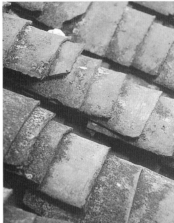
Abb. 6 Die Ziegel- schalen messen durch- schnittlich 15 x 17 x 0,8 cm
