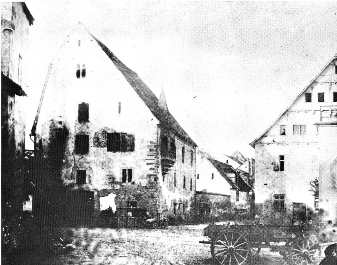
Abb. 1 Fotografische Ansicht des Salmansweilerhofes, der «Herberge», von Osten vor ihrem Abbruch 1865.
