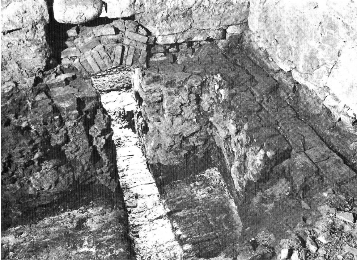
Abb.11 Schürlöcher und Ofeninneres nach der Ausgrabung. Erkennbar sind die weissen Kalkreste und der vertiefte Schürkanal.
