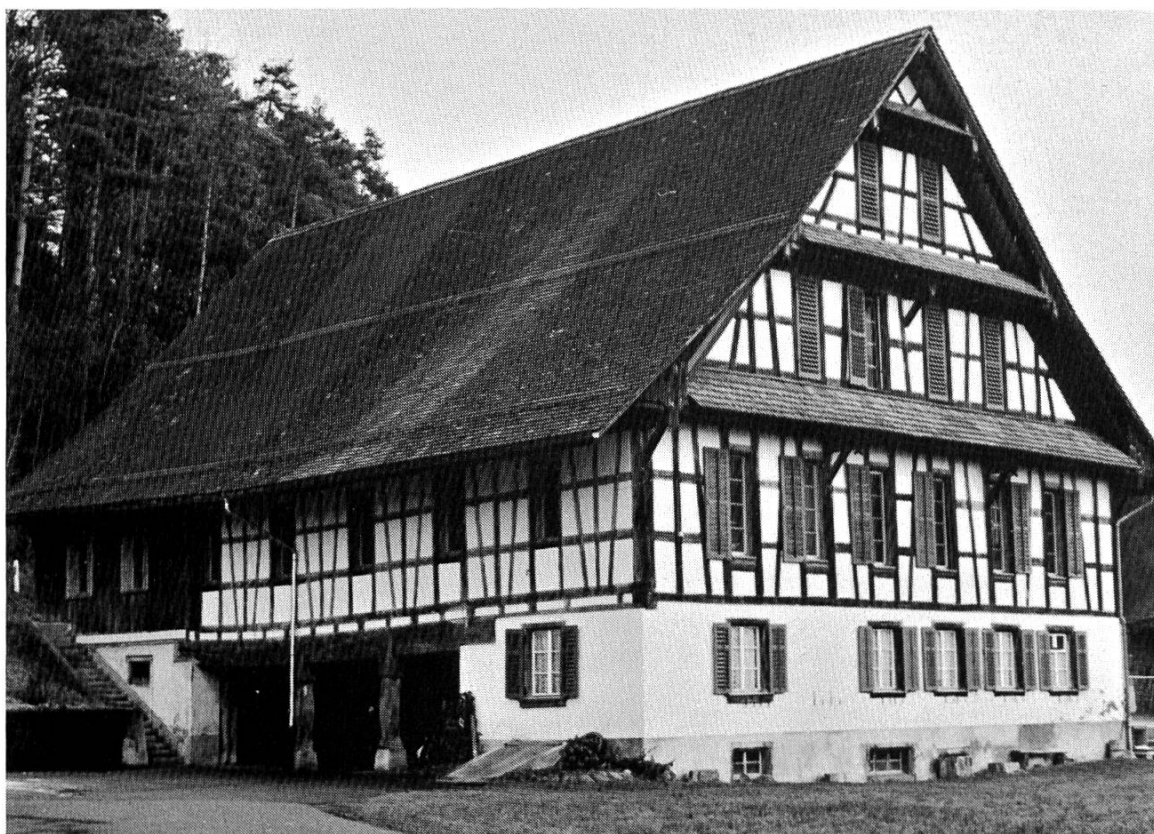
Abb. 29 Die ehemalige Ziegelhütte in Baar, 1606 erbaut.
