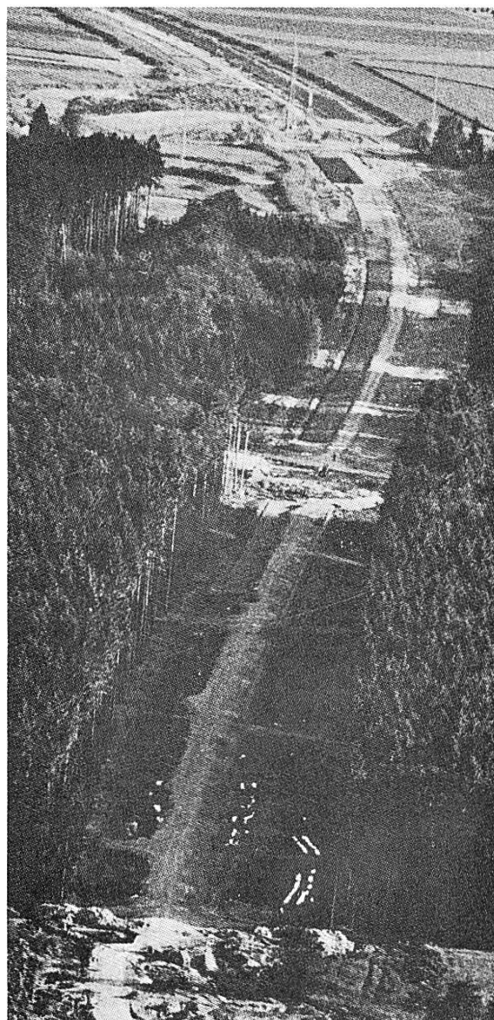
Abb. 4 Neben Feldern und Wäldern werden durch den Strassenbau auch immer wieder seltene und unersetzliche Lebensräume zerstört.
