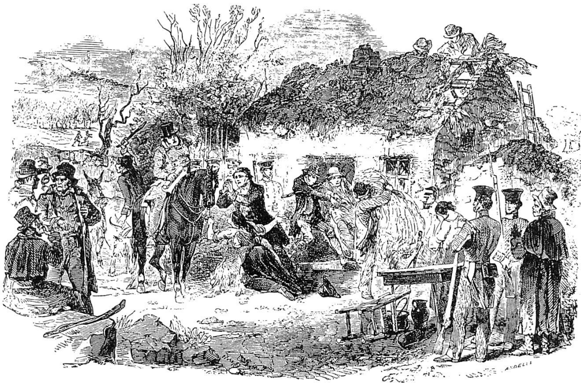
Abb. 1 Eine irische Pächterfamilie wird durch Dachabdecken und Hauswüstung vertrieben. Illustration erschienen in den «London Illustrated News» vom 6. Dezember 1884.
