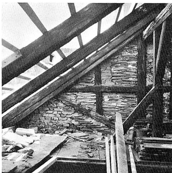
Abb. 4 «Brand- mauer» zwi- schen den Häusern St.- Urban- Gasse 67 und 69. Die Ausfa- chungen der Ständerkon- struktion bestehen zu einem gros- sen Teil aus zweckfremd verwende- ten Kloster- ziegeln.
