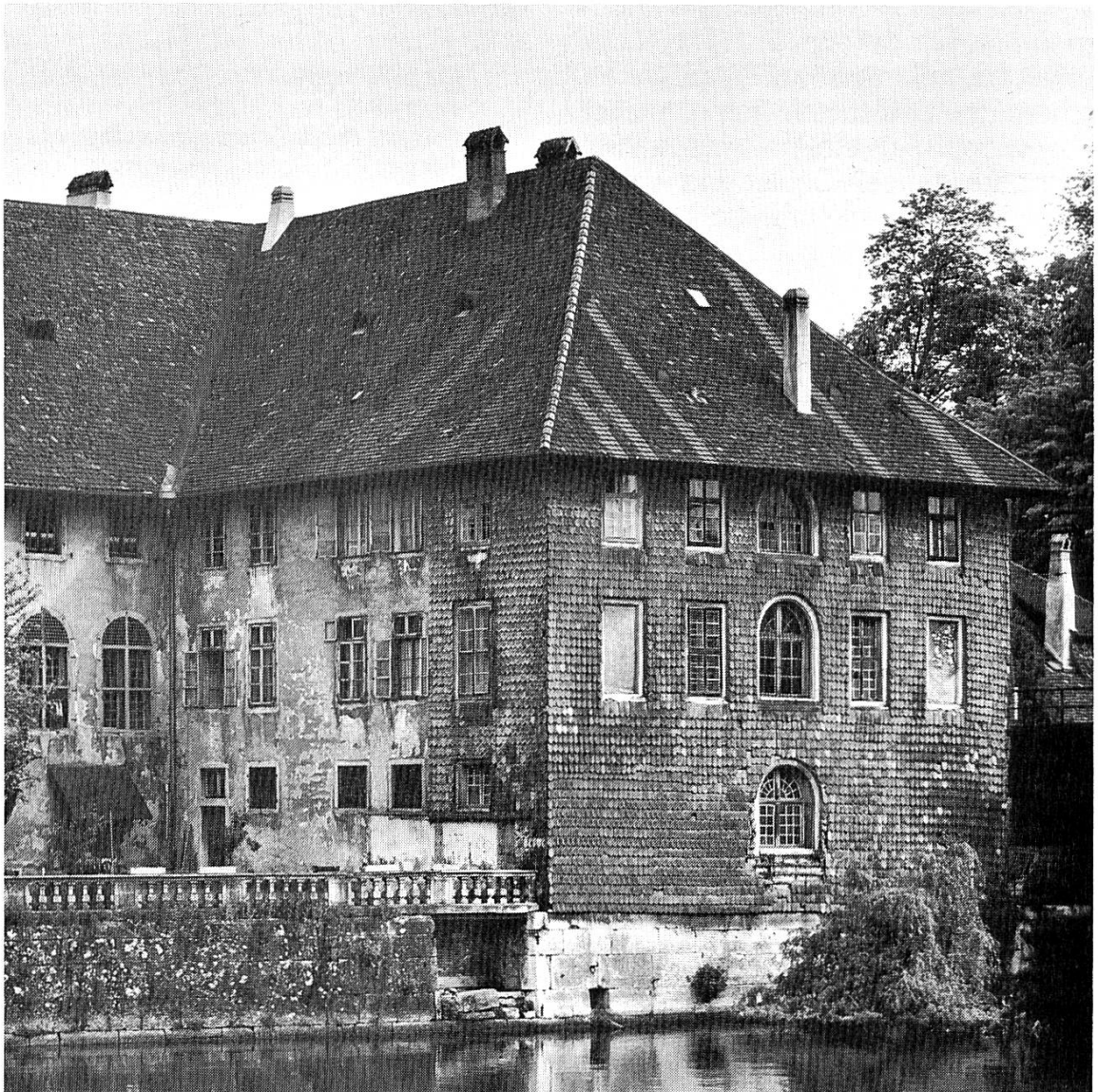
Abb. 8 Alter Spital in der Vor- stadt. Westflügel erbaut im letzten Jahr- zehnt des 18. Jahrhun- derts. Der Bau war ursprünglich ringsum glatt ver- putzt. Erst 1835 (19) hat man seine Nord- fassade mit einem Zie- gelmantel versehen. Vgl. Ziegel Typ i, Seite 20.
