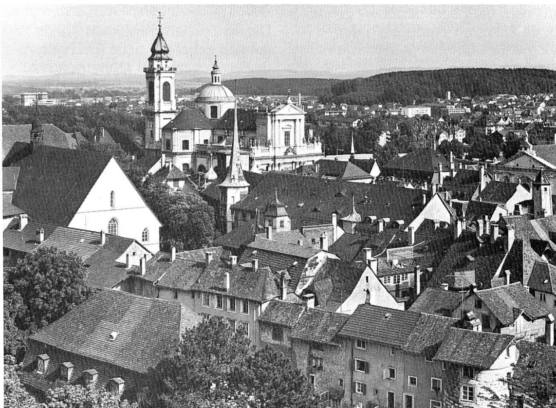
Abb. 1 Blick vom Turm der reformierten Kirche über die Dach- landschaft der Altstadt. Foto Ernst Räss †, Solo- thurn, um 1965
