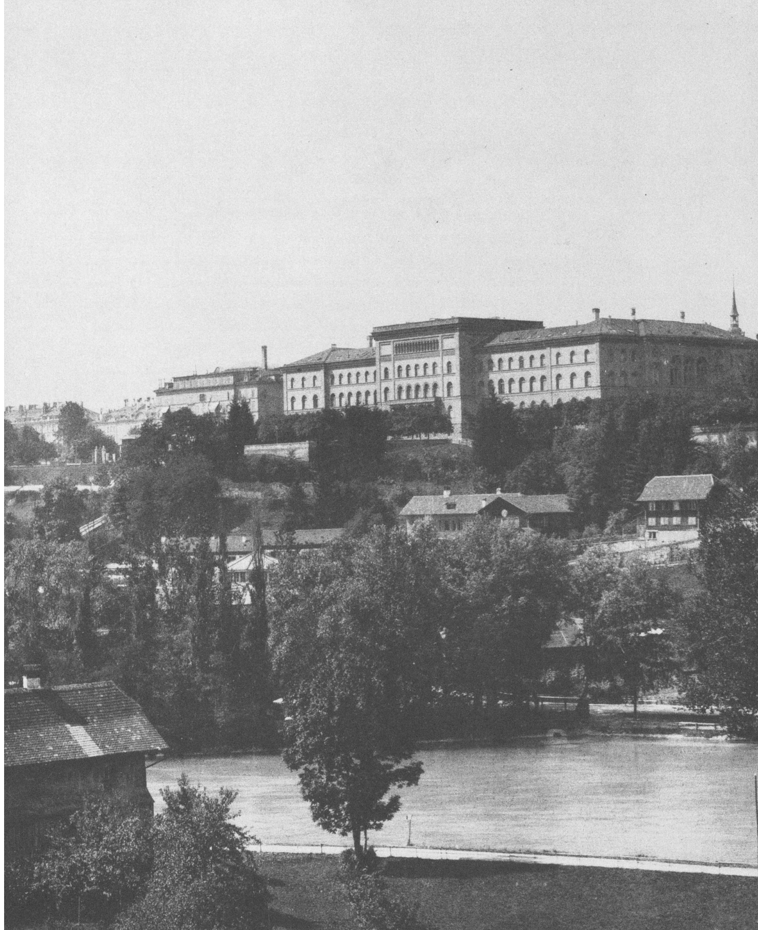
Baulücke: Altes Kasino, eingekeilt zwischen Bundesrathaus und Verwaltungsgebäude. Fotografie, 1892. – ETH-Bibliothek Zürich, Bildarchiv, Fotograf unbekannt, Ans_08789-FL, Public Domain Mark.
