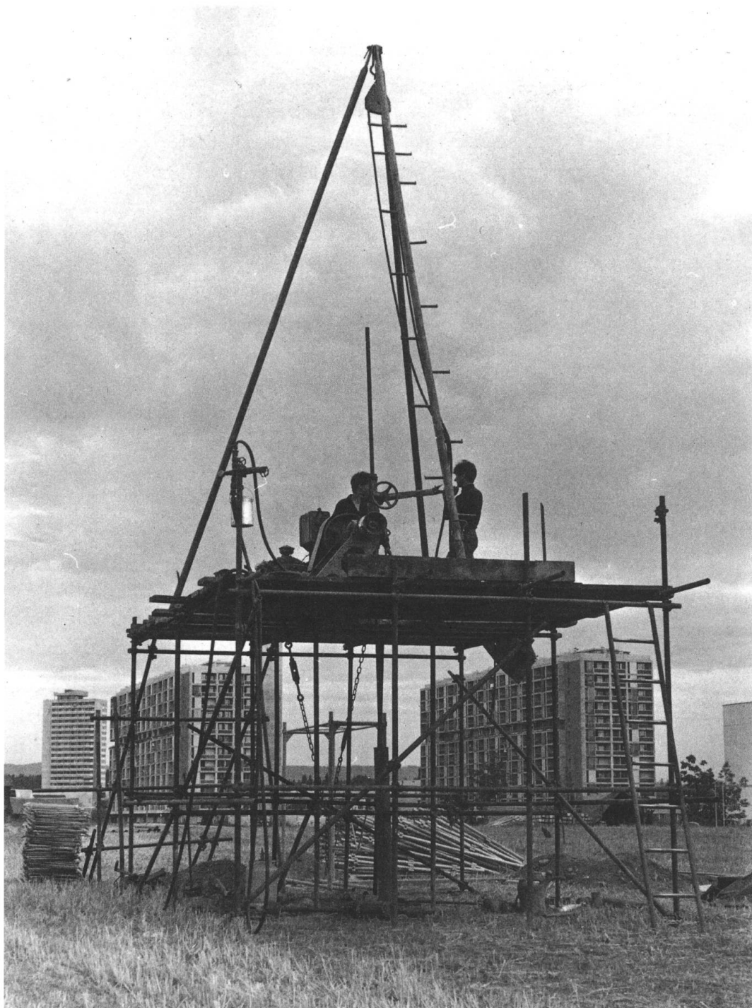
Bodensondierung für das Hochhaus K, um 1967. Im Hintergrund die beiden Scheibenhäuser C und D. – Ortsarchiv Bümpliz, P 1830.
