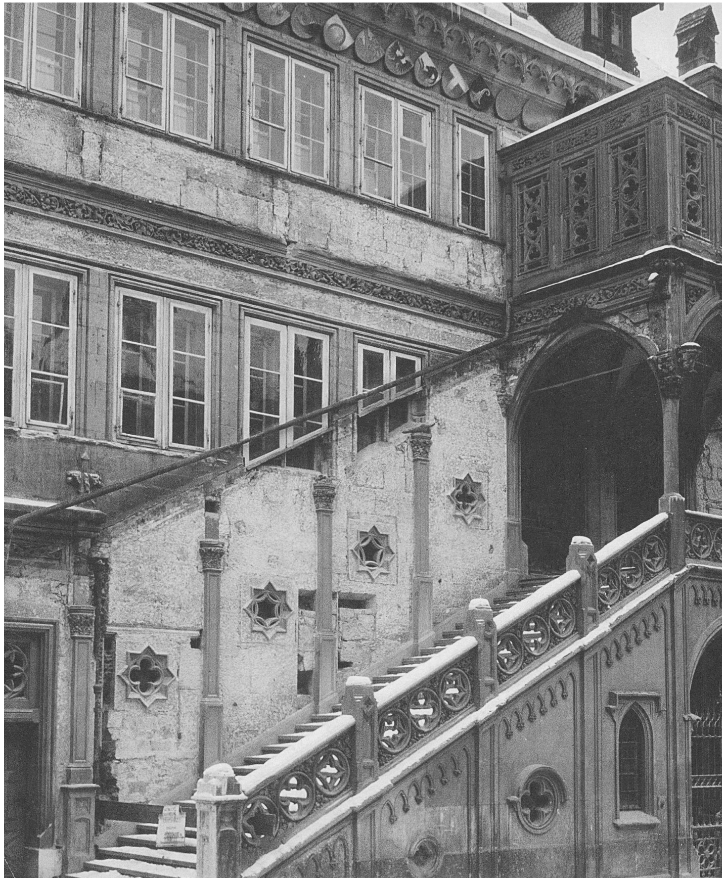
Umbau Rathaus 1940–1942: Westliche Hälfte der Rathaus-Fassade nach dem Abbruch des Daches über der Rathauptreppe. Die Masswerkbrüstung der Treppe, die Wandverkleidungen oder auch der Uhrenkasten stammen vom neugotischen Umbau, der Wappenfries mit Baldachin und die Gewölbe des Vorbaus dagegen sind alt und werden erhalten bleiben. – StAB, BB 05.7.846, Nr. 100. Foto: Hans Steiner, Dezember 1940.
