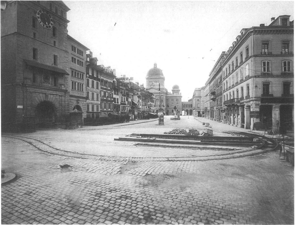
Abb. 10 1919 liess die Stadt Bern beim Käfigturm ein gepflastertes Strassenstück mit dem damals neu aufkommenden Asphalt überziehen. Während der Bauzeit mussten die Trams umgeleitet werden. Unterhalts- und Bauarbeiten gehören seit jeher zum Alltag einer Stadt. Viele Unternehmer und manchmal auch die Bauherrschaft liessen die verschiedenen Phasen fotografisch dokumentieren und am Schluss in Alben zusammenstellen. Anonym: Provisorische Tramführung beim Käfigturm, Bern, anlässlich der Asphaltierung, 18. Juli 1919, Papierabzug 16,7 x 22,6 cm.
