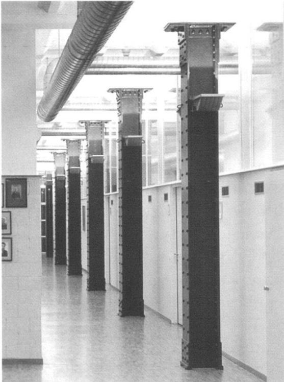
... über die genieteten Walzprofilstützen
