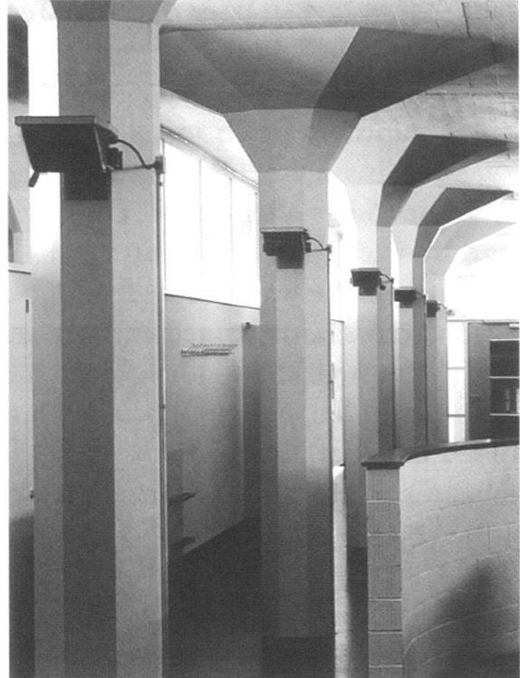
... zu den Eisenbeton-Pilzstützen der neuen
