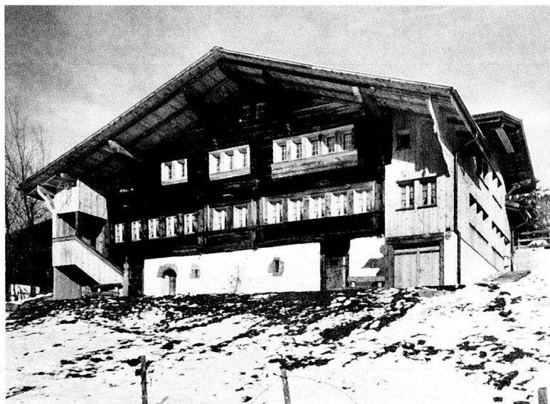
LAUENEN «Alter Spittel», Nr. 233. Mächtiger, breitlagernder Bau, 1. Hälfte 16. Jahrhundert, schlichte Rillen- und Stabzier, Stuben mit «Heidenwelbi». Gesamtanierung, Fassadenrestau- rierung 1990.
