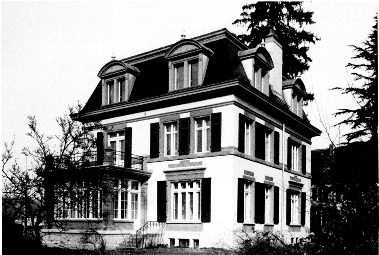
Neubarocke Villa Beaulieustrasse 72 nach der Renovation 1992.
