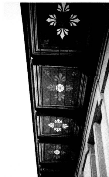
Erneuerte Vorscher-Malerei am Länggass-Schulhaus II.
