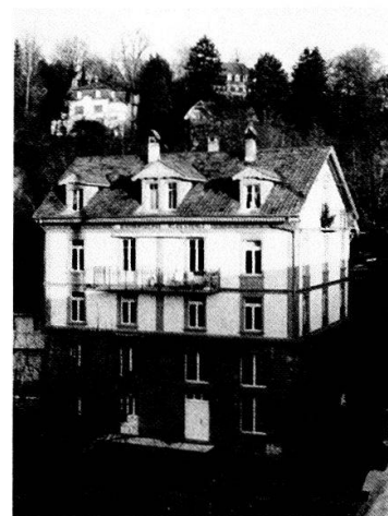
Klösterlistutz 20: Westfassade, Zustand 1992.
