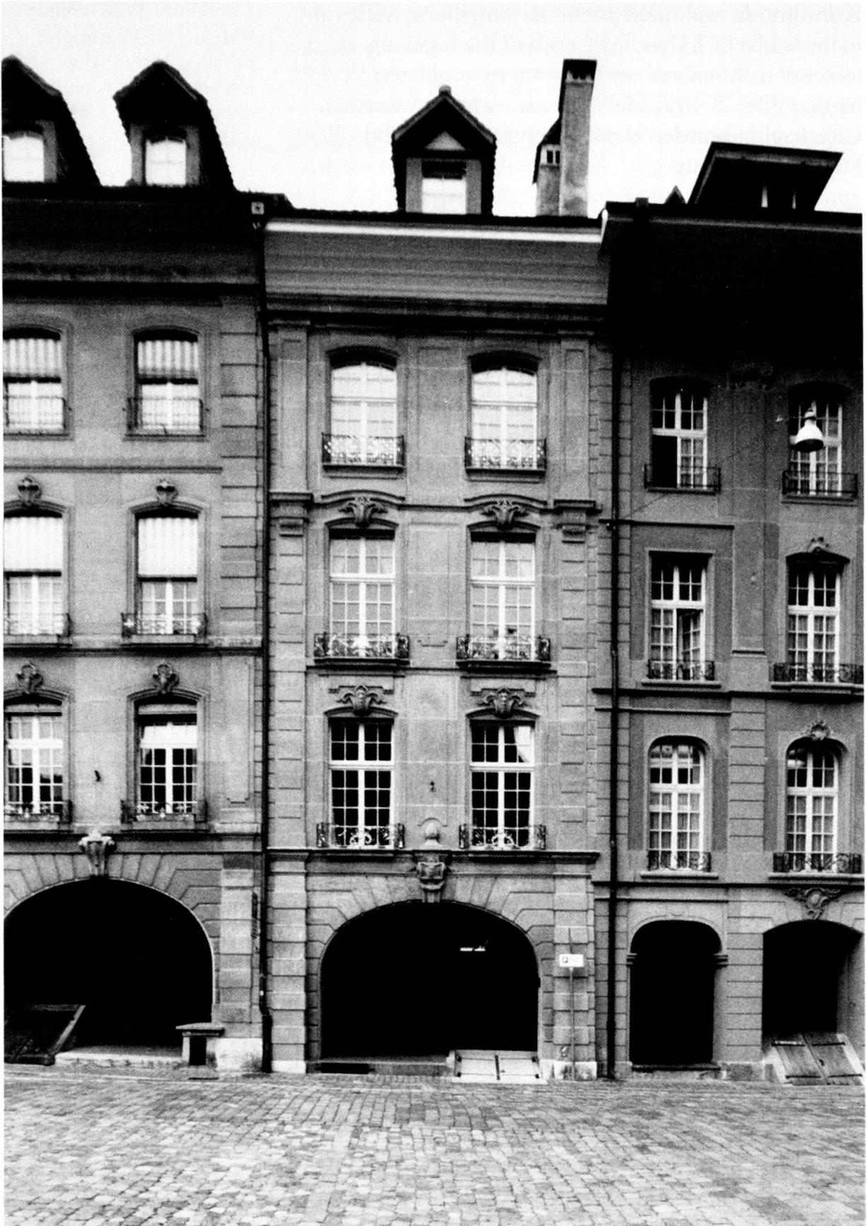
Münstergasse 26: Fassade mit neuer Fensterteilung.
