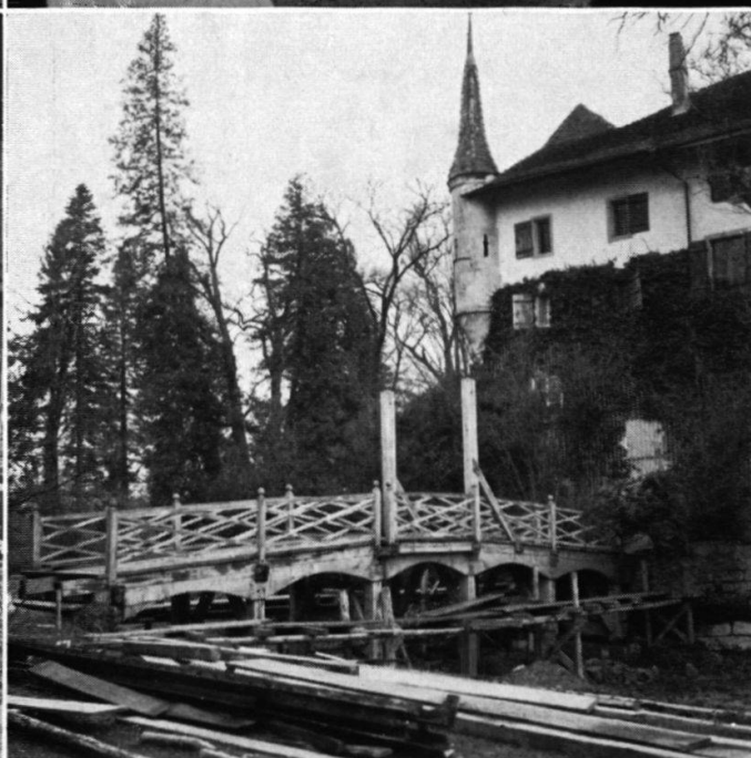
Schloß Landshut, Rekonstruktion der alten Zugbrücke
