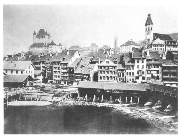
Abb. 9 Foto der Altstadt in den 1870er-Jahren. Rechts im Vordergrund befindet sich die untere Schleuse. Ganz links im Bild erkennt man unterhalb des Schlossberges die zwei Mühlengebäude, unter denen je ein Kanal durchfloss. Davor stand zudem eine Sägerei, die ebenfalls die Wasserkraft nutzte.
