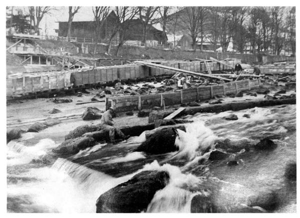
Abb. 3 Bauarbeiten an der Aaresohle im Schwäbis, zwischen 1916 und 1926. Wegen der Rückwärtserosion der Aare nach der Aare-Zulg-Korrektion musste im Schwäbis die Flusssohle ab 1877 in mehreren Etappen mit Steinblöcken gesichert werden. Damals entstanden die Aarefälle. Zu Beginn der 1960er-Jahre verschwanden diese im Rückstau des Wehrs, das damals für den Betrieb des neuen Elektrizitätswerkes errichtet wurde.
