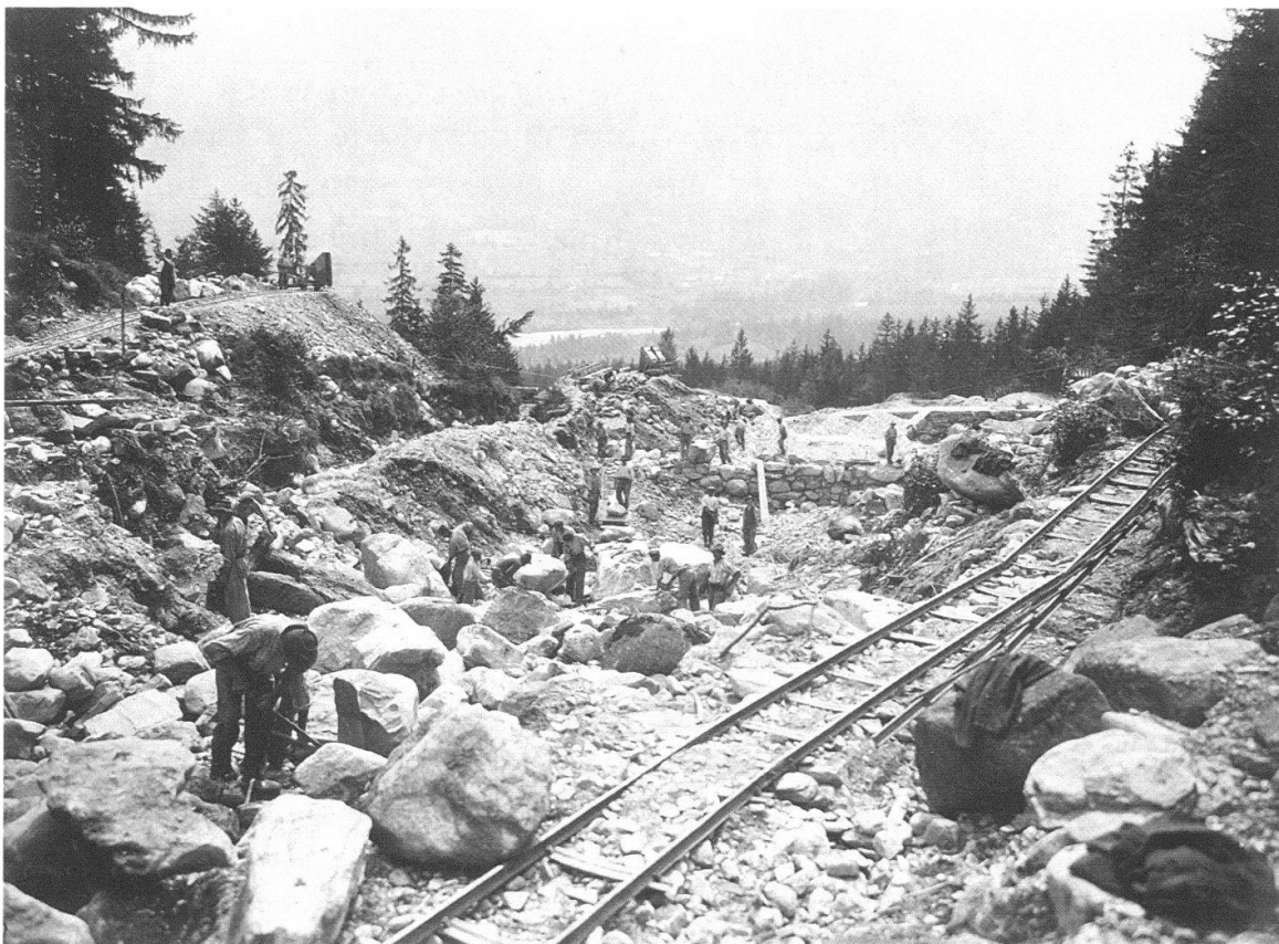
Abb. 1 Baustelle am Unterlauf des Heitibachs in Wengi bei Frutigen um 1913. Der Einsatz von Maschinen war nicht überall möglich, deshalb kam oft menschliche Arbeitskraft zum Zug.
