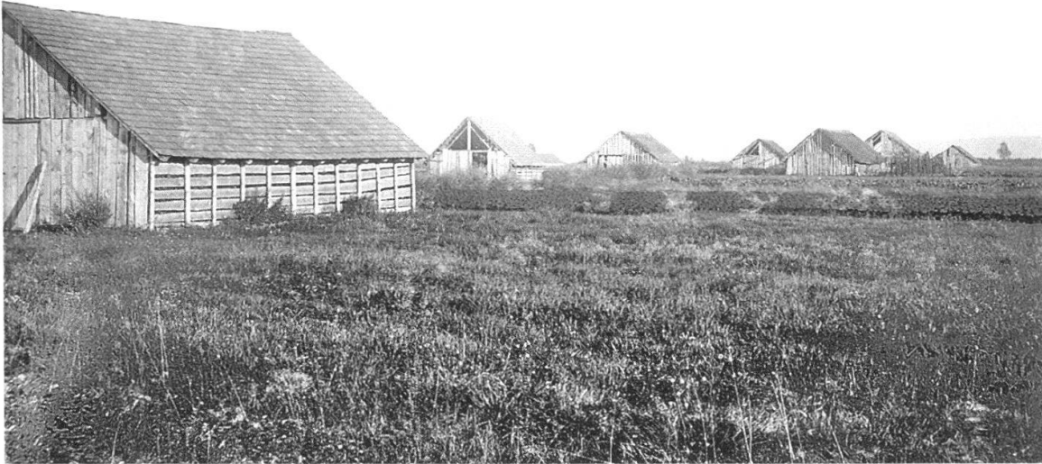
Abb. 8 Turbenhütten bei Witzwil 1897. Die Grösse der Baracken kann als Mass für die Volumina der zu dieser Zeit geförderten Torfmenge dienen. Zwischen und vor den Hütten sind die geometrischen Strukturen von Buschreihen oder kleinen Kanälen sichtbar, die auf die Entwässerung zurückzuführen sind (vgl. Abbildung 7).
