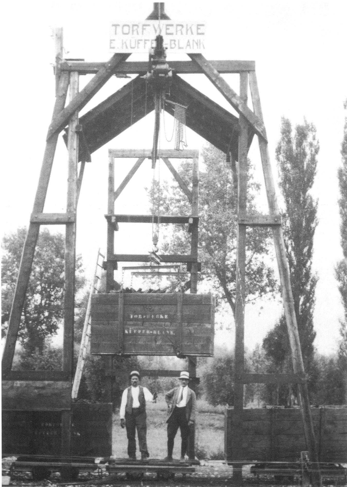
Abb. 10 Mit dieser Holzcontainer-Hebeanlage lud die Firma Ernst Küffer-Blank die oben offenen Container ab den Rollwagen auf Lastwagen, die den Torf nach Bern brachten, und auf Pferdefuhrwerke, die nach Neuenburg führen. Auf der Foto aus der Zeit des Ersten Weltkriegs präsentiert sich Ernst Küffer-Blank mit Hut, Krawatte und Reithosen; links neben ihm steht ein Arbeiter. Auf den Geleisen ganz vorne transportierte das Unternehmen die Container vom Torffeld zur Hebeanlage und zurück.
