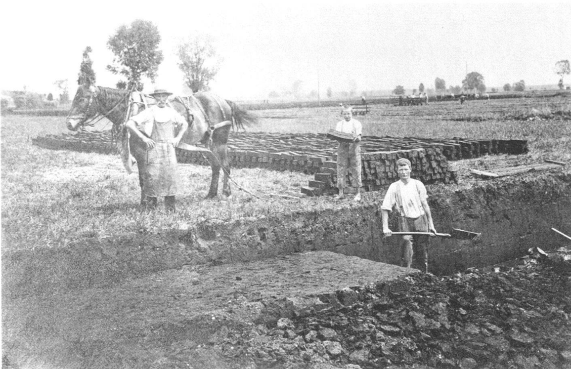
Abb. 2 Landwirte beim Torfstechen bei Ins im Ersten Weltkrieg. Vorne steht ein Torfstecher, der eine «Turbe» auf seinem Stecheisen hat. Diese Torfquader wirft er dem dahinter stehenden Knaben zu, der die Turben auf ein Brett am Boden legt. Der Bauer links transportiert den Torf mit dem Pferdezug an den Trocknungsplatz im Grasland daneben. Das zweite Brett dahinter ist noch leer. Die Stichtiefe im Graben beträgt zwei Turbenlängen, also etwa 70 Zentimeter. Die nicht nutzbare Humusschicht (Abdeckete) hat eine Dicke von etwa 40 Zentimetern. Im Vordergrund liegen Torfreste und Humus aus dem Vorjahr. Im Hintergrund sind mehrere Gruppen ebenfalls am Torfstechen.
