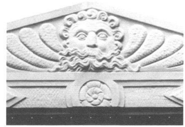
Gerechtigkeitsgasse 33: Detail Fenstergiebel des ersten Obergeschosses.
