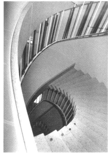
Schauplatzgasse 21: Treppenaugie der Anlage von 1963.
