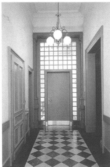
Parlamentsgebäude: Neue Tür als Korridor- abschluss.
