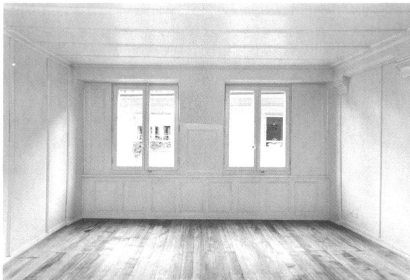
Brunngasse 56: Gassenzimmer im ersten Obergeschoss mit sicht- barer Primärkonstruktion, Konsolen, Streichbalken und Bohllendecke.
