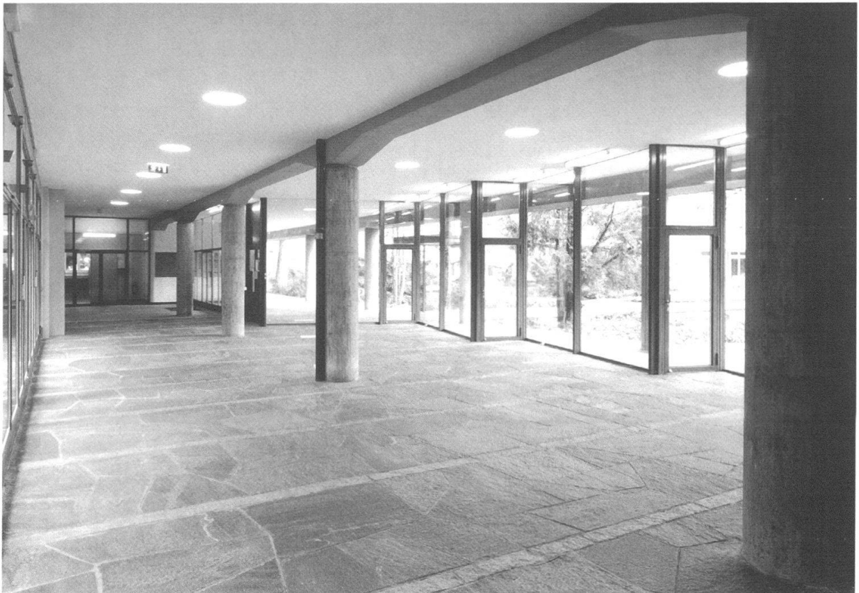
Schulhaus Marzili: Eingangs- und Pausenhalle mit Sicht auf den neuen, gestaffelten Glasabschluss.
