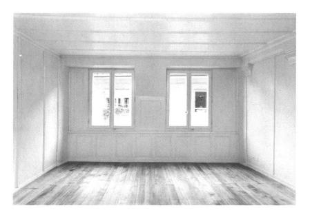
Brunngasse 56: Gassenzimmer im ersten Obergeschoss mit sichtbarer Primärkonstruktion, Konsolen, Streichbalken und Bohlendecke.
