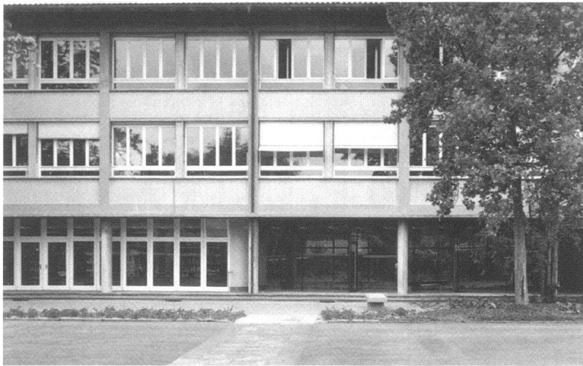
Schulhaus Marzili, Brückenstrasse 73: Ausschnitt Südostfassade mit neuem Abschluss der erdgeschossigen Pausen- halle.
