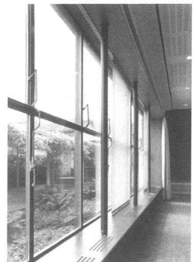
Originale, instand gestellte Stahlkonstruktion der Aulabefensterung.
