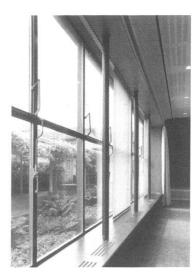
Originale, instand gestellte Stahlkonstruktion der Aulabefensterung.
