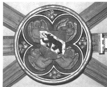
Berner Münster: Nordportal West, Schluss- stein Zustand vor und nach der Konservierung; die Substanz ist konsolidiert, aber nicht ergänzt.
