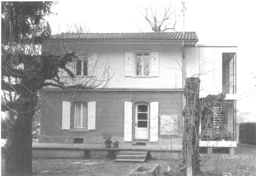
Wärterhaus: Altbau mit Anbau.
