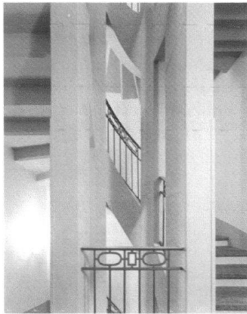
Herrengasse 36: Ausschnitt des historischen Treppenhauses mit Gelän- der von 1908.
