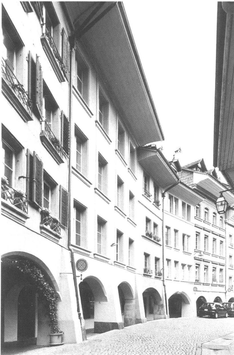
Brunngasse 54–58: Gassenfassaden nach der Renovation 2005.
