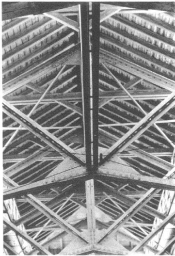
Reitschule: Knotenpunkt Stahl- konstruktion in der Grossen Halle.
