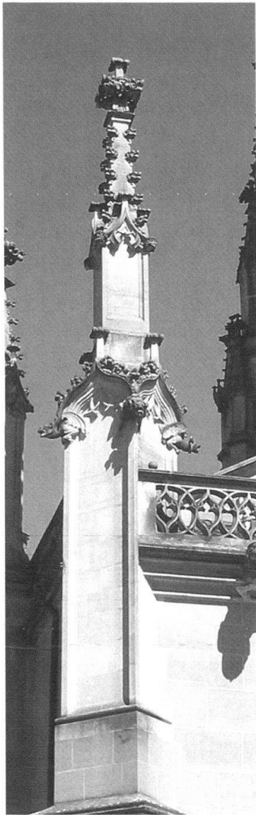
Münster: Westwerk Eckfiale Nord, im Zustand zehn Jahre nach dem Totalersatz in Oberkirchner Sandstein.
