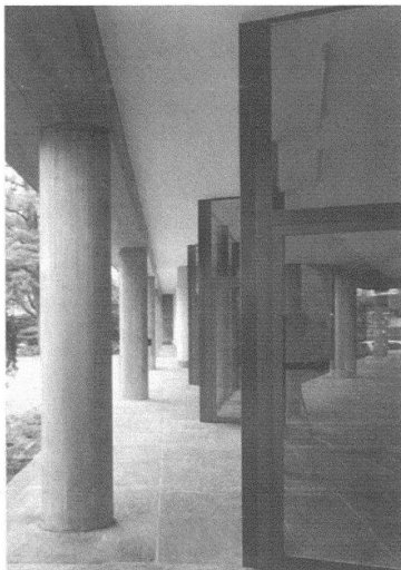
Schulhaus Marzili: Die neue Verglasung der Pausenhalle ist zur Säulenreihe zurückgesetzt.
