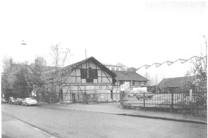
Von-Roll-Areal: Gesamtansicht der Schopf- und Remisebauten Fabrik- strasse 16 und 18 B.
