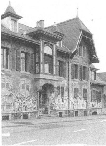
Reitschule: Saniertes Wohnhaus an der Neubrückstrasse mit renoviertem Erker.
