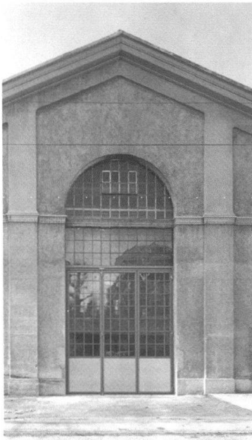
Neues Anlieferungstor, integriert in die bestehende Verglasung auf der nördlichen Hallenstirnseite.
