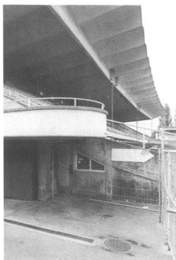
Stadion Wankdorf: Tribüne mit Balkon.
