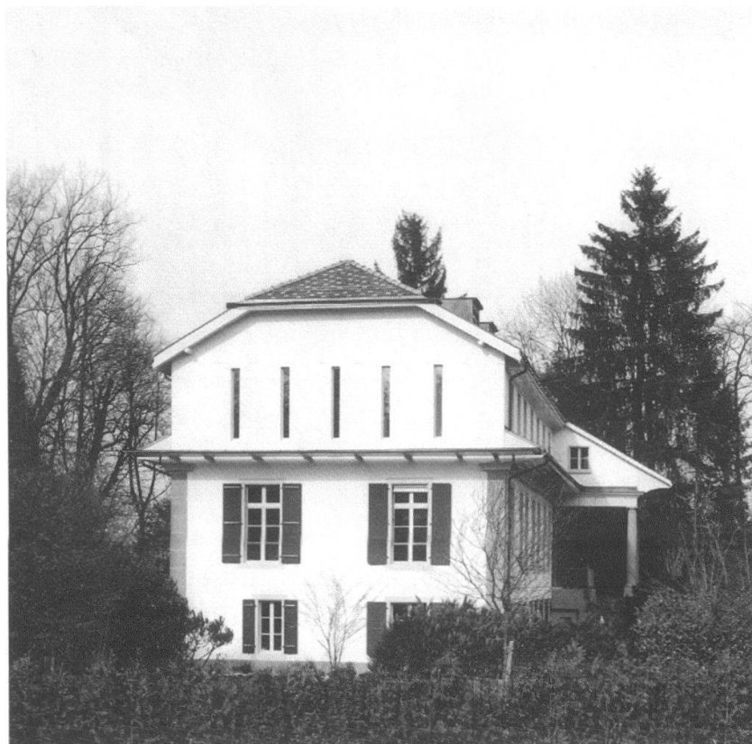
Bellevue: Fassade Süd mit re- konstruierten Fenster- öffnungen im Erd- und Obergeschoss, neuem Vor- dach und Fensterschlitz im Dachgeschoss.
