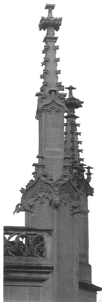
Münster: Westwerk Eckfiale Süd, Schlusszustand nach Kon- servierung/Restaurierung.
