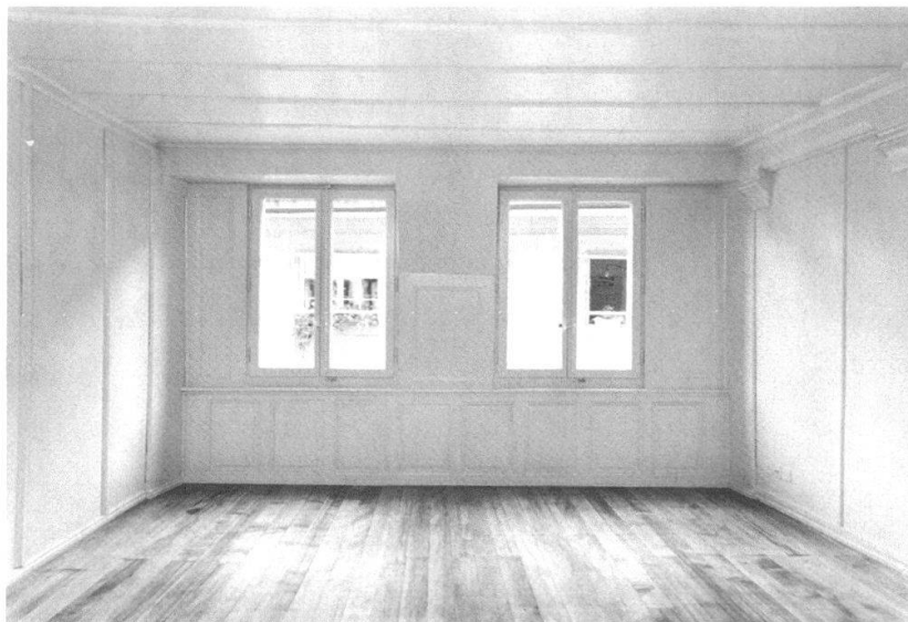
Brunngasse 56: Gassenzimmer im ersten Obergeschoss mit sicht- barer Primärkonstruktion, Konsolen, Streichbalken und Bohhlendecke.
