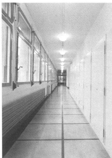
Kantonales Laboratorium, Baltzerstrasse 5: Korridorzone mit sanierten Einbauten und Befens- terung sowie erhaltener Restbestand der Rohrlei- tung und des Euböolith- bodenbelages.
