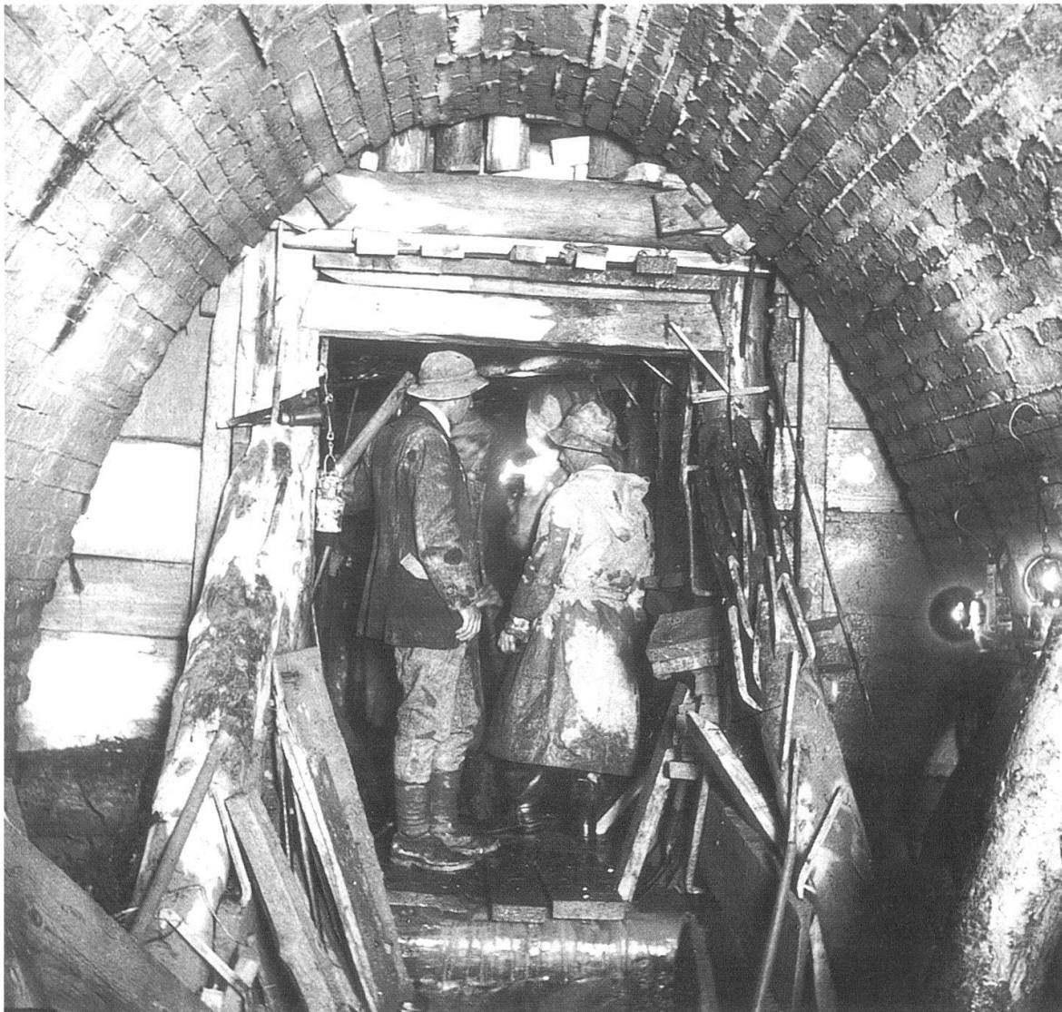
Abb. 8 Ein markantes Grossprojekt des Tiefbauamtes der Stadt Bern war der zwischen 1923 und 1926 erstellte, 1040 Meter lange Sulgenbachstollen. Dank diesem gelangte das Abwasser aus dem westlichen und südwestlichen Teil der Stadt erst unterhalb der Lorrainebrücke in die Aare, was die Verunreinigung des Aarewassers zwischen Marzili und Lorraine stark verminderte. Die während der Bauarbeiten entstandene Foto zeigt eine Innenansicht des Stollens und verdeutlicht dessen ausserordentliche Grösse.
