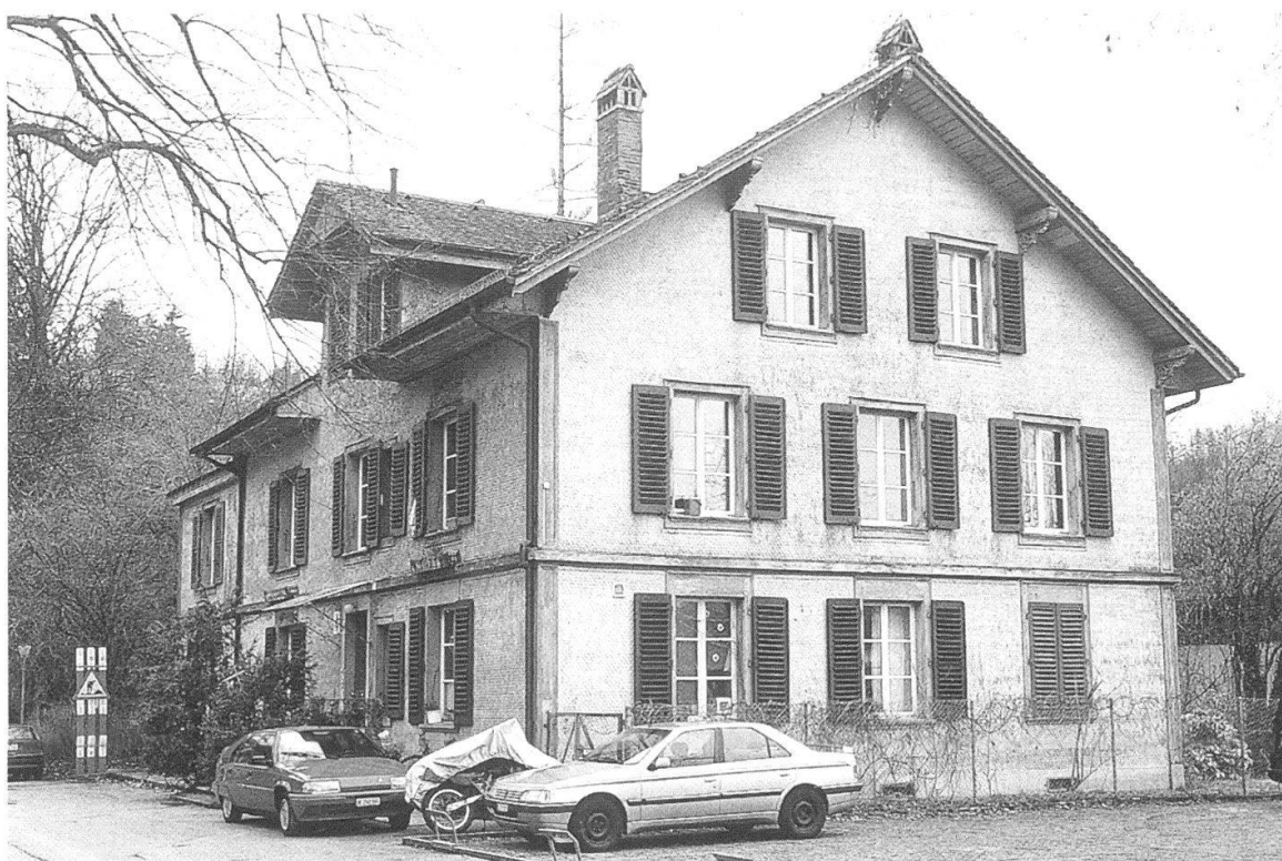
Abb. 10 Die Direktionsvilla im Jahr 2002. Das Gebäude sieht von aussen eher unscheinbar aus, da es keinen protzigen Fassadenschmuck aufweist und die Fassade schlecht unterhalten ist. Im Innern umfasst die Villa zwei grosse Sechszimmerwohnungen, die dem bürgerlichen Lebensstil der Direktorenfamilien angemessen waren.
