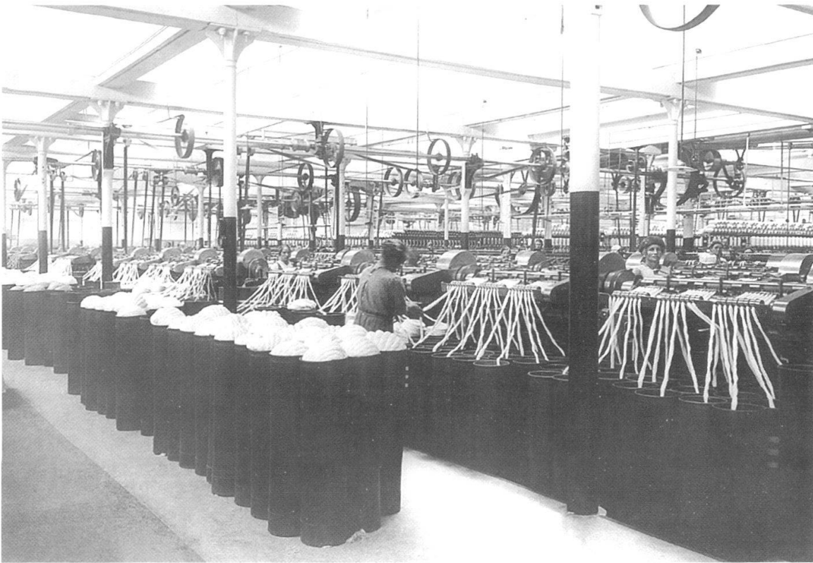
Abb. 9 Ein Saal der Spinnerei Felsenau in der Zwischenkriegszeit. Die in «Kannen» von der Karderie angelieferten Baumwollbänder wurden hier in die Flyermaschinen eingeführt, die das Band streckten und leicht drehen. So entstand das Vorgarn von einigen Millimetern Dicke, das im nächsten Arbeitsgang zu Garn gesponnen wurde.
