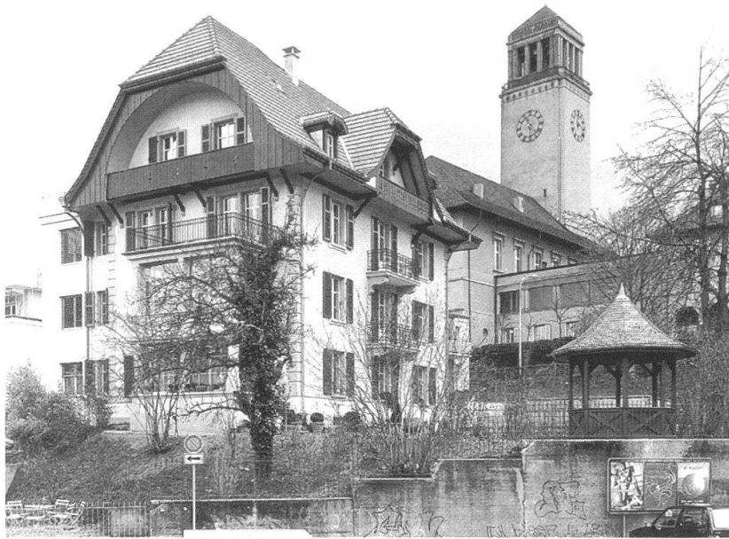
Hopfgut, Munzingerstrasse 17: Restauriertes Gebäudeäusseres mit rekonstruierter Dachform und neu erstelltem, unpassendem Anbau.
