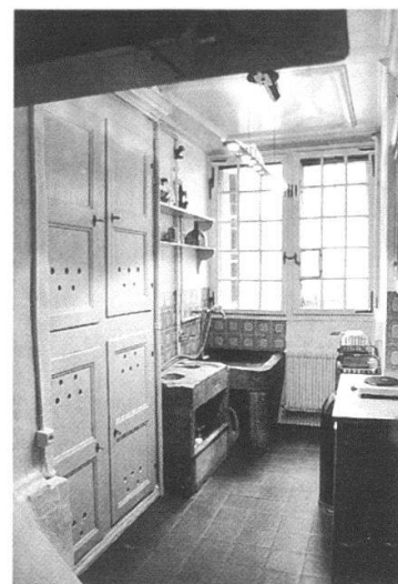
Junkerngasse 35: Küche mit Sandsteinherd und -ausguss sowie Ergänzung mit neuzeitlichen Apparaten.
