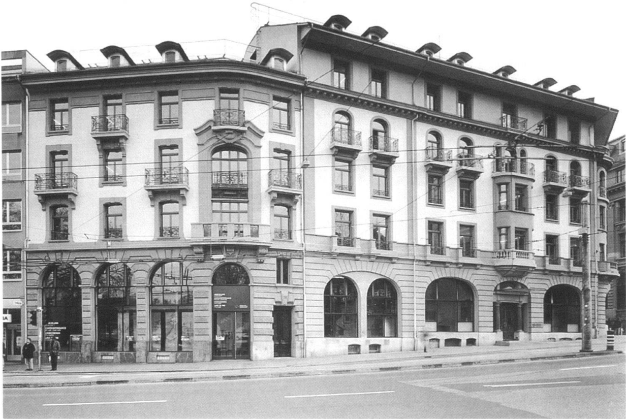
Bollwerk 27, 29: Die beiden Hauptfassaden.
