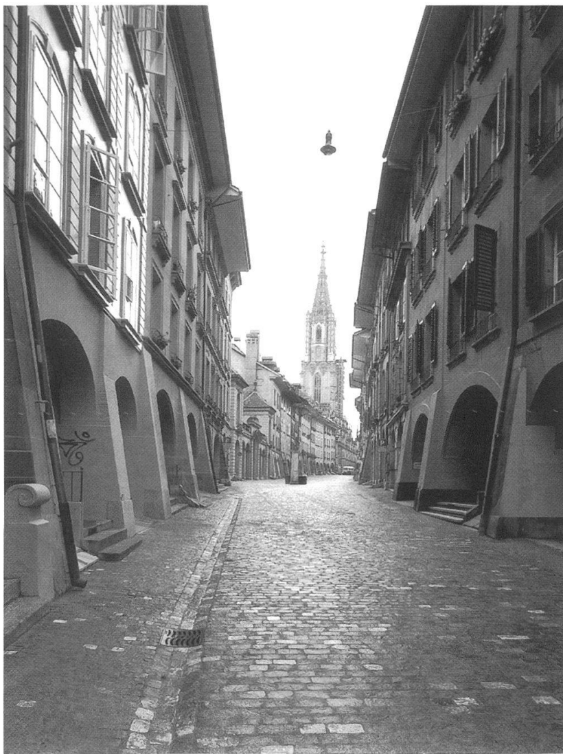
Pflasterung Junkerngasse: Neupflasterung mit seitlichem Wasserlauf in der unteren Gassenhälfte.
