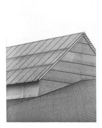
Depotstrasse 43: Firstoblicht mit in Glas eingegossener Fotovoltaikanlage.
