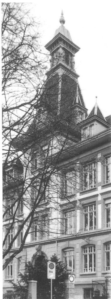
Bitzius-Schulhaus, Bitziusstrasse 15: Turm nach Restaurierung.
