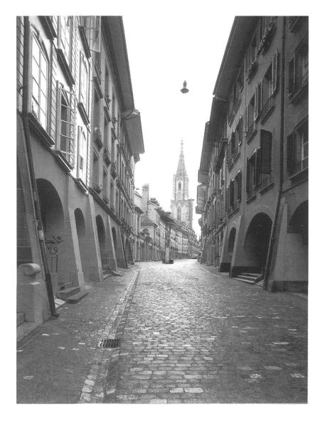
Pflästerung Junkerngasse: Neupflästerung mit seitlichem Wasserlauf in der unteren Gassenhälfte.
