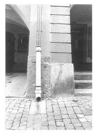
Pflästerung Junkerngasse/ Kreuzgasse: Detail der Neupflästerung mit einer der vier wiederhergestellten offenen Dachentwässerungen der Schattseite der Junkerngasse.
