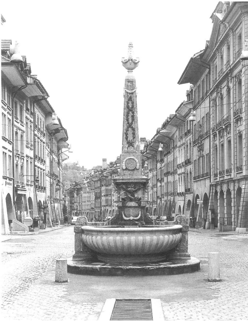
Kreuzgass-Brunnen von 1778/79 nach Reinigung und Wiederversetzen am alten Standort.
