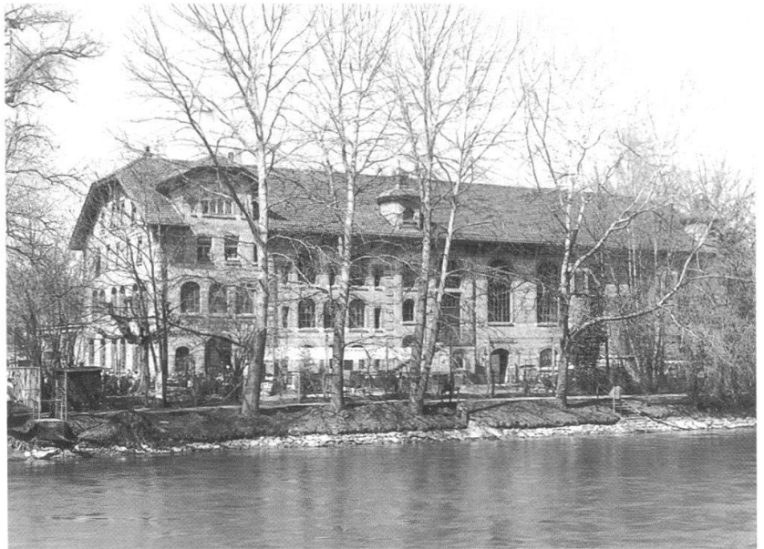
Dampfzentrale, Marzilistrasse 47: Aareseitige Fassadenansicht, vom Dalmaziquai aus aufgenommen.
