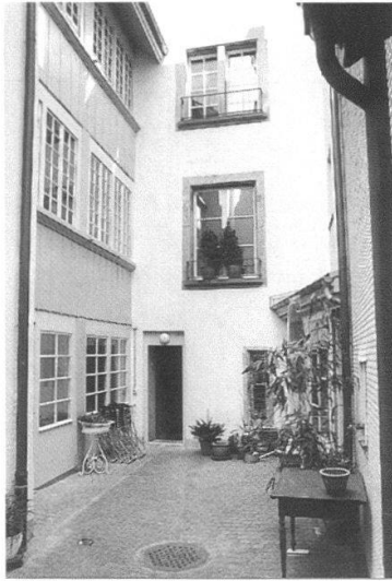
Gerechtigkeitsgasse 62/ Postgasse 55: Hoffassade des Hausteils an der Postgasse.
