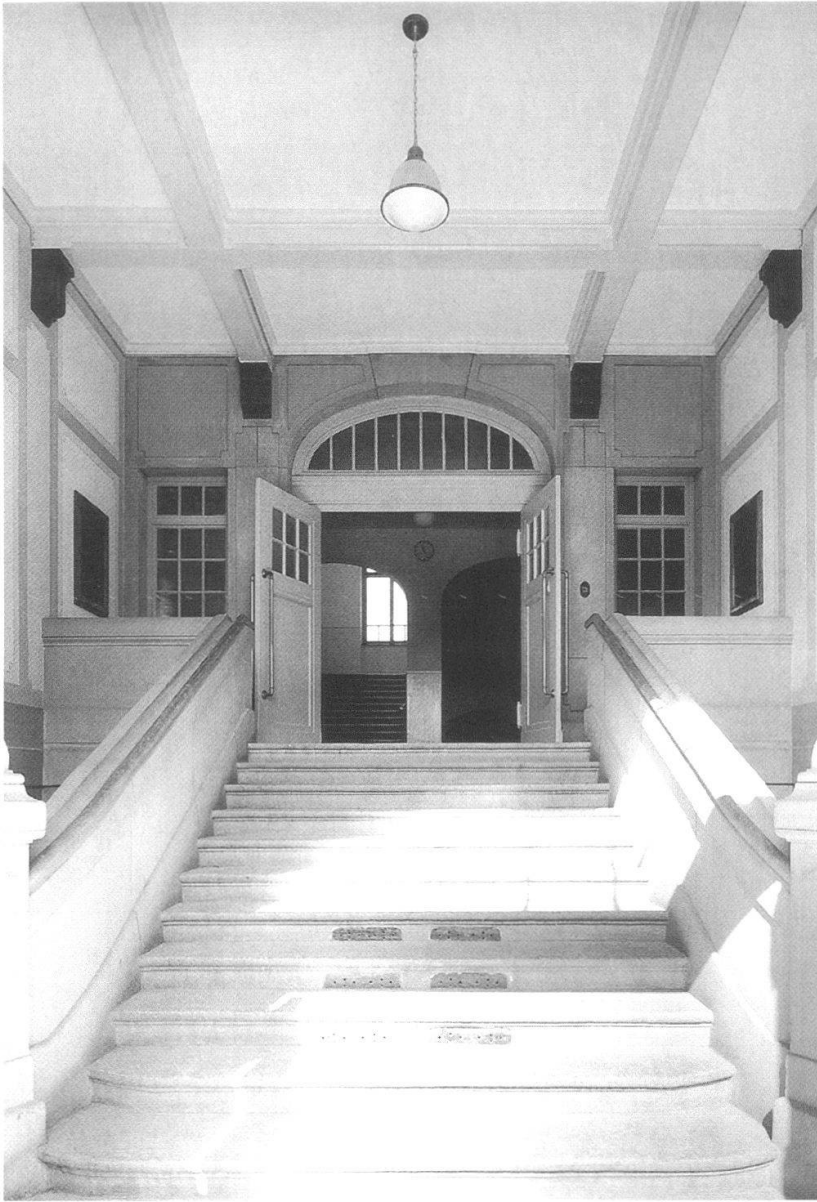
Bitziusstrasse 15: Die restaurierte, ursprünglich offene Eingangshalle.
