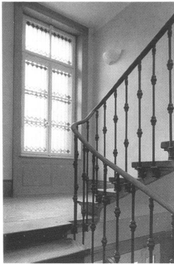
Sulgenbachstrasse 5: Treppenhaus mit restaurierter Marmorwandmalerei.
