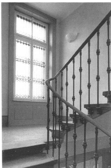
Sulgenbachstrasse 5: Treppenhaus mit restaurierter Marmorwandmalerei.
