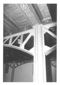
Zeughausgasse 2: Stützenelement mit Fachwerkträger und bemalter Balkendecke.
