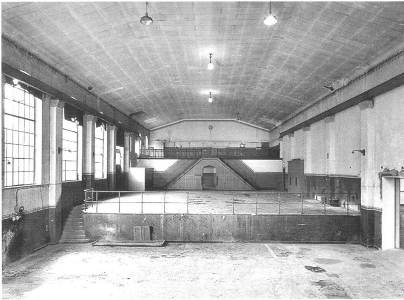
Marzistrasse 47: Turbinenhalle vor der Sanierung mit charakteris- tischer Antreppung des Bodenniveaus.
