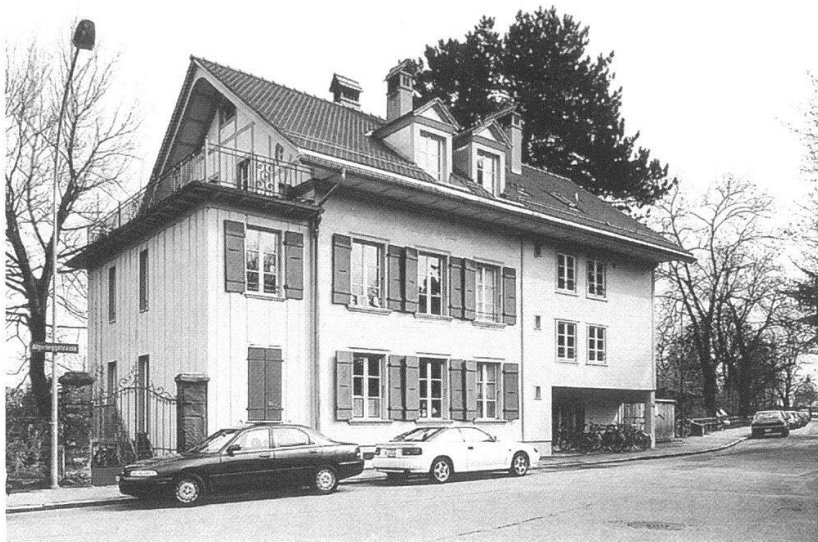
Alpeneggstrasse 10: Strassenansicht mit instand gestellter Fassade und wieder aufgebaute Dach mit Biberschwanzziegeln.
