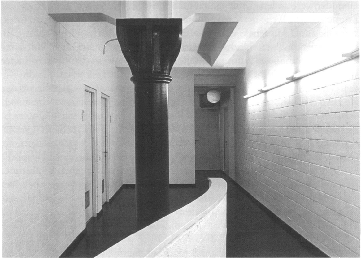
An den Stützen sind die verschiedenen Bauetappen der Fabrikerweiterung ablesbar: Von den Gusseisenstützen im Untergeschoss des ältesten Fabrikteils von 1898 ...
