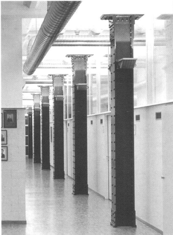
... über die genieteten Walzprofilstützen des Erweiterungsbaus von 1907 (Blick in das Erdgeschoss, Historisches Institut) ...
