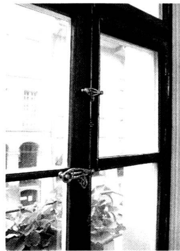
Gerechtigkeitsgasse 25: Originales Fenster mit äusserer Aufdoppelung.
