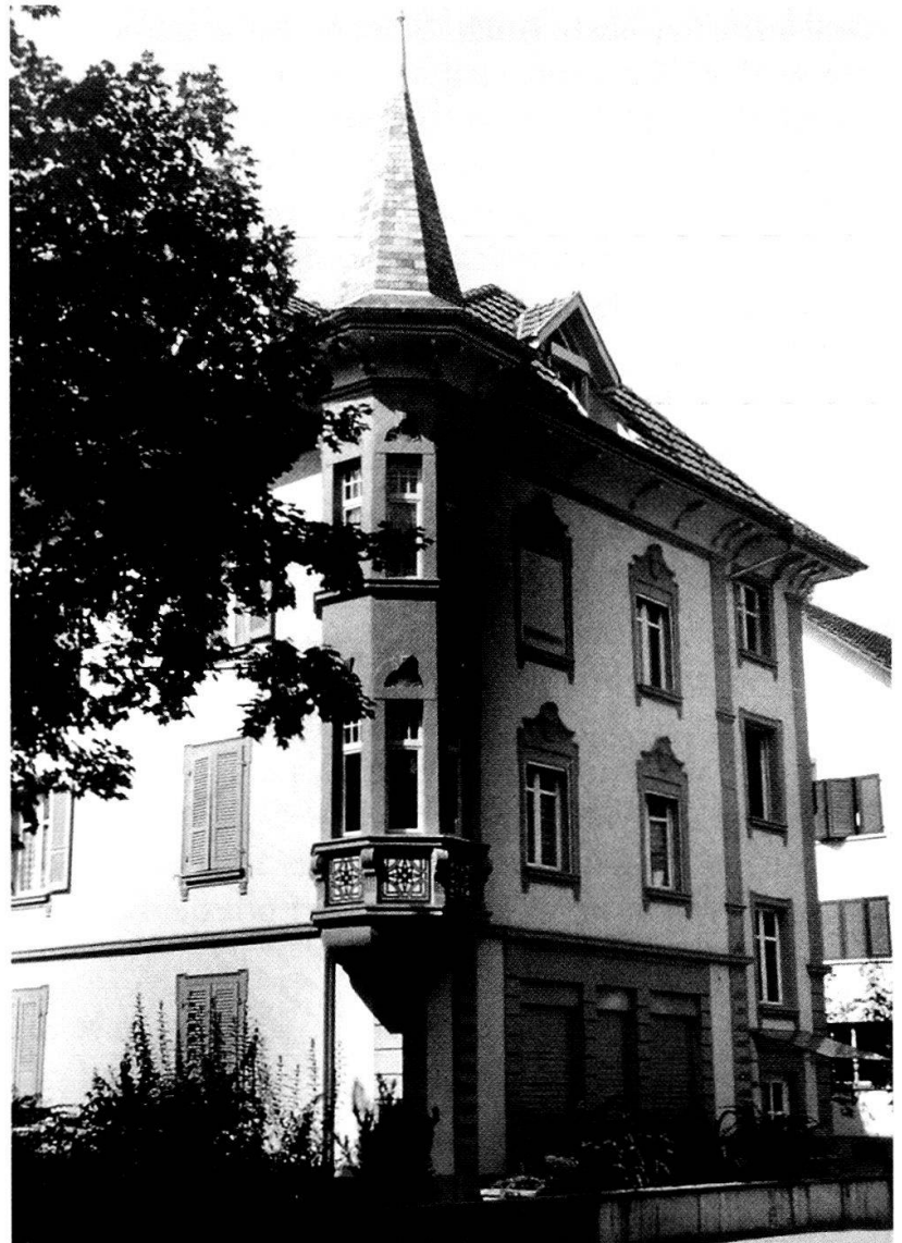
Bümplizstrasse 180 vor dem Umbau.
