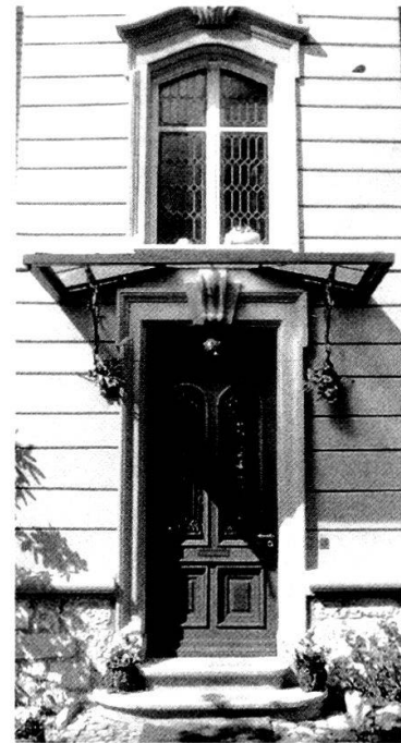
Alpenstrasse 25/27: Detail der Eingangspartie.
