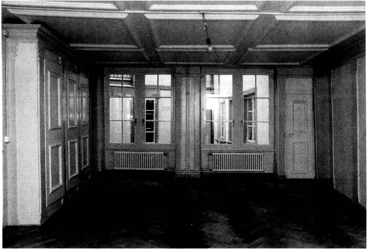
Brunngasse 70: Pilastertäfer im Hofzimmer des 2. Ober- geschosses.
