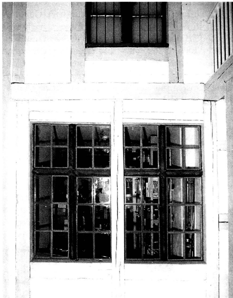
Marktgasse 53: Restaurierte Eichenfenster mit Fensterkreuz und Halbstäben im Treppen- haus-Lichthof.
