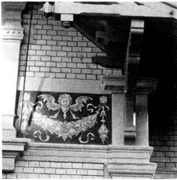
Seftigenstrasse 2: Renoviertes Sgraffito-Dachfussdekor mit Putten und Fruchtgehänge.
