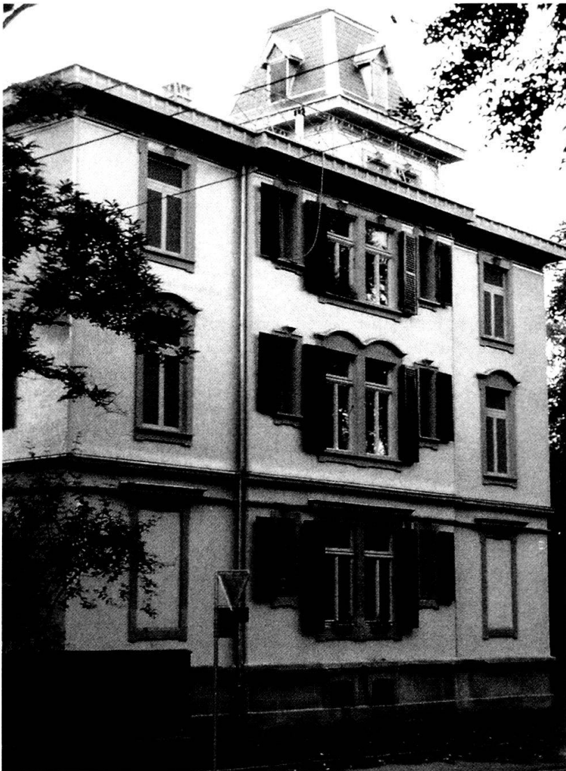
Das Haus Höherweg 38 mit Flachdach und Treppenturm von Osten.
