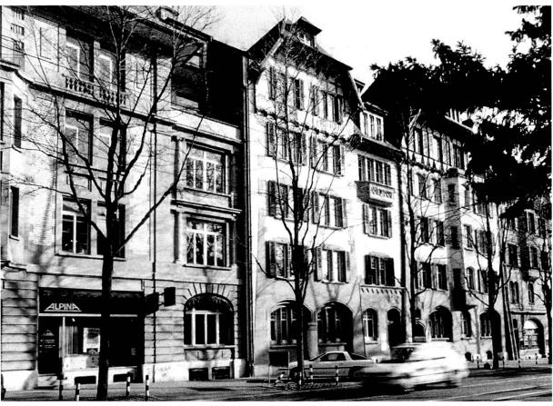
hielt im Giebelbereich eine Eternitverkleidung, die Mittelgewände der Fenster wurden ausgebrochen und durch grossflächige Aluminiumkonstruktionen ersetzt; Jalousieläden und die eicherne Haustüre wurden entfernt.
