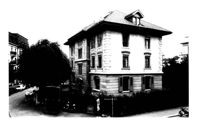
Dabei ergänzte man die bestehenden Giebellukarnen mit minimal dimensionierten Dachflächenfenstern. Die flächige Erscheinung des zu ersetzenden Dachbelags wurde mit der Verwendung eines Falzbiberziegels wiederhergestellt.
