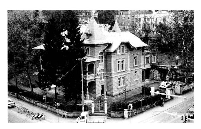
Die hervorragend gestaltete und klar proportionierte Doppelvilla Alpenstrasse 25/27 wurde 1897 vom Architekten Albert Gerster in Neubarock-Formen erbaut. Der Zustand der Bauzeit des in dunkelrotem Sichtbackstein mit Sandsteingliederungen ausgeführten Gebäudes blieb – zumindest was das Haus Nr. 27 betrifft – im wesentlichen erhalten.
