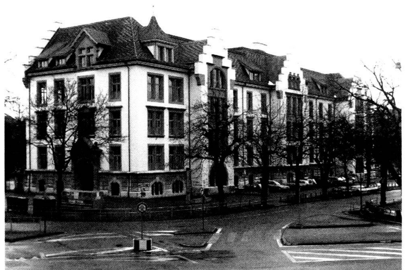
Das Spitalackerschulhaus nach der Sanierung.
