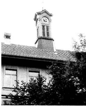
Neufeldstrasse 20: Der «Thürmli»-Dachreiter wurde bis hin zu den Blattgold-Uhrzeigern detailgetreu restauriert.
