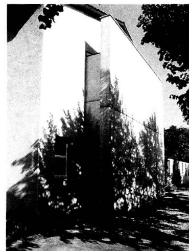
Abdankungskapelle Schosshaldenfriedhof: Die zurückverschobene Chorwand von aussen.
