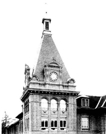
Viktoriaschulhaus: Der restaurierte Turmhelm.
