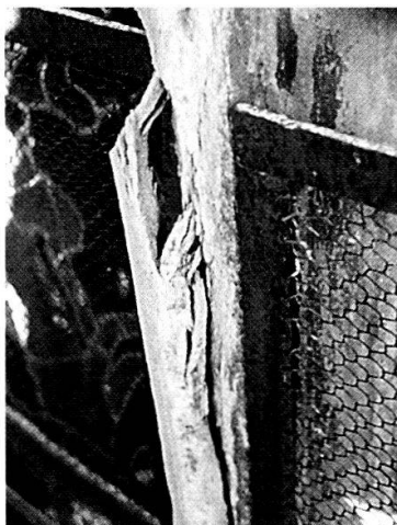
Berner Münster: Obergaden- front F: In Auflösung begriffener Masswerkteil vor der Auswechslung.
