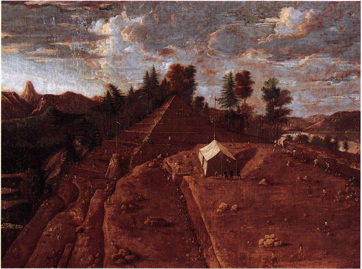
Arbeiten am Kanderdurchstich 1711/12. Zeitgenössisches Ölgemälde. Anonym. Photographie: S. Rebsamen (Bernisches Historisches Museum, Inv.-Nr. 5067).
