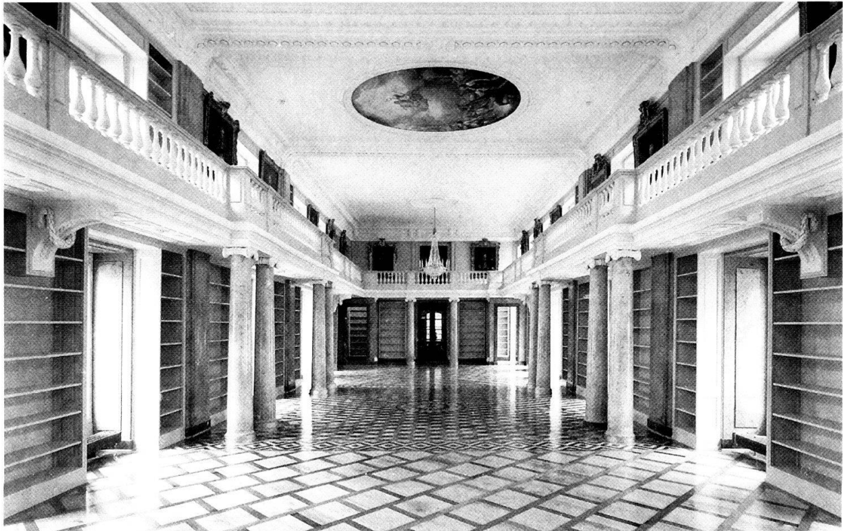
Abb. 3: Blick in den Schultheissensaal der Stadt- und Universitätsbibliothek, nach der Restaurierung 1974, vor der Möblierung. Der Berner Saal folgt dem Typus der Emporenbibliothek, kombiniert aber Säulen und Konsolen als Emporenträger in wirkungsvoller Akzentuierung der Mitte und der Schmalseiten. Die zurückhaltende Eleganz des Saals beruht auf der geringen Saalbreite und der zweiseitigen Belichtung und auf der reduzierten Instrumentierung. Photographie: G. Howald.
