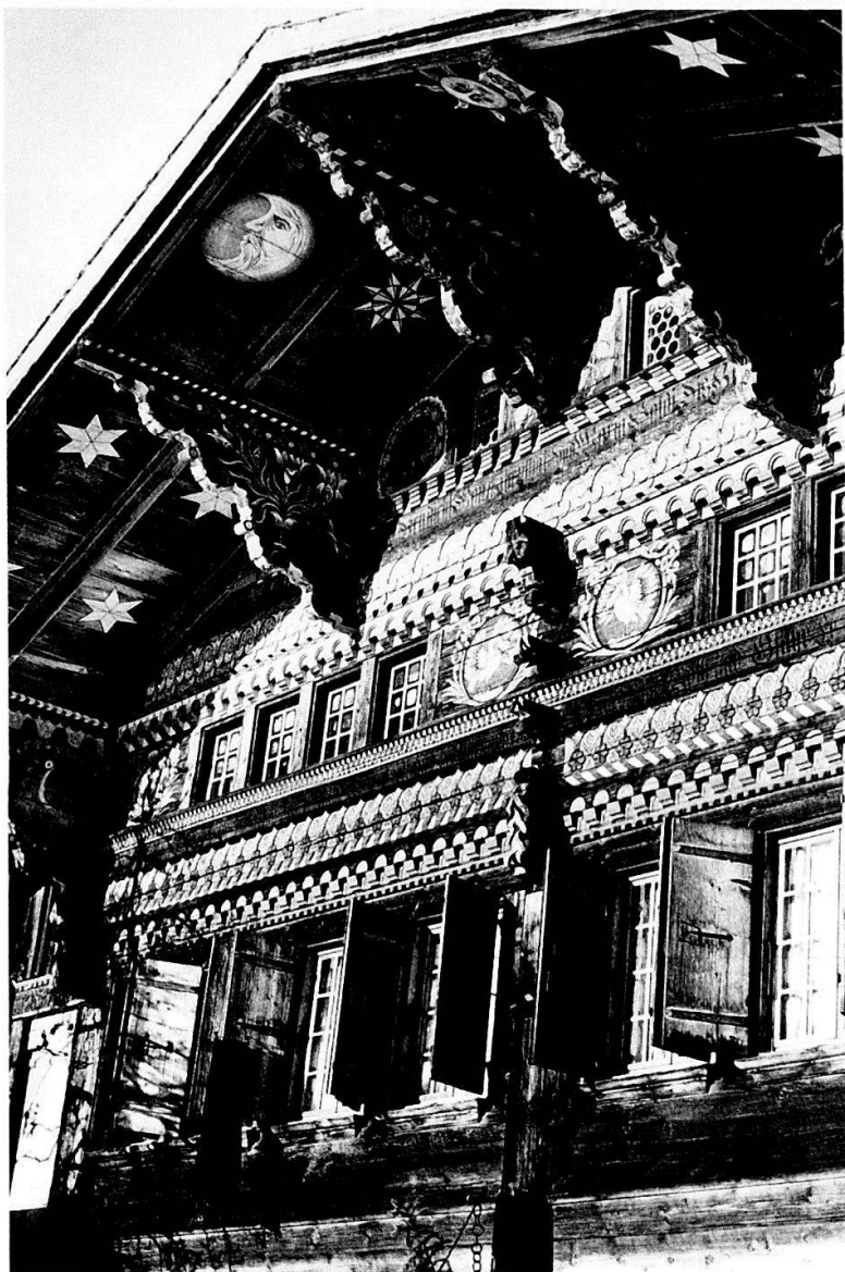
SAANEN Äbnet, Wohnhaus, Nr. 628. Reich bemaltes und beschnitztes Wohnhaus, erbaut 1755 durch Zimmermeister Peter Russi für Bendicht von Siebenthal und Maria Haldi. Um- und Ausbau, Malerestau- rierung 1973.
