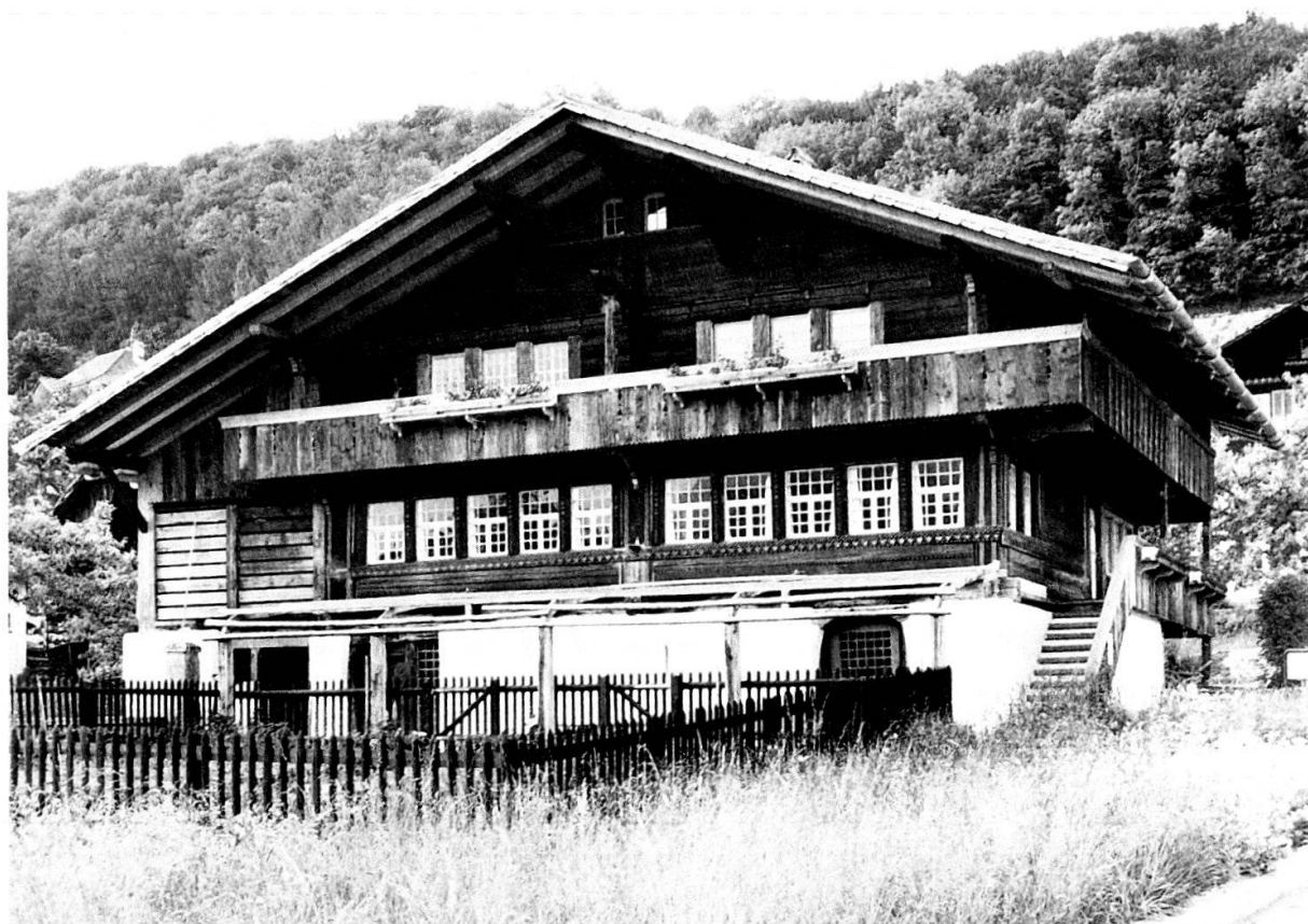
Spiez, Heimat- und Rebbaumuseum; Spiezbergstrasse 48, erbaut 1728, renoviert 1984/85.
