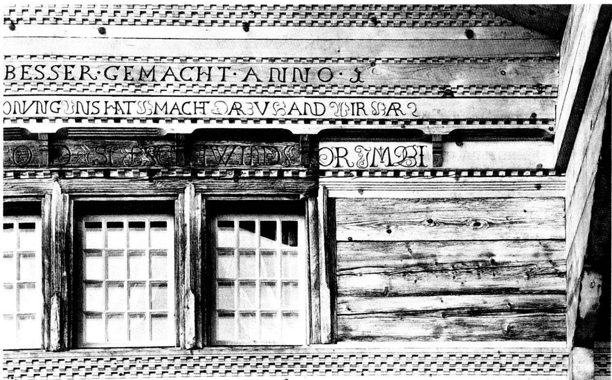
Die Antiquainschrift am 1655 erbauten Bauernhaus «Rüdeli» in Blumenstein (Nr. 216) war durch Fäulnis und Holzkäfer stark zerstört. Noch lesbare Teile wurden auf die ersetzten Balken übertragen, die vollständig verlorenen Zeilenenden blieben unergänzt.
