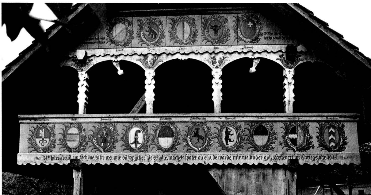
«Erneuert im Chriegsjahr 1942» und «Walther Soom Heimiswil hat ihn gemalt»; diese an den Lauben aufgemalten Inschriften zeugen von der Renovierung des prächtigen, 1759 erbauten Wappenspeichers in Wynigen (Mühlegässli 48B).
