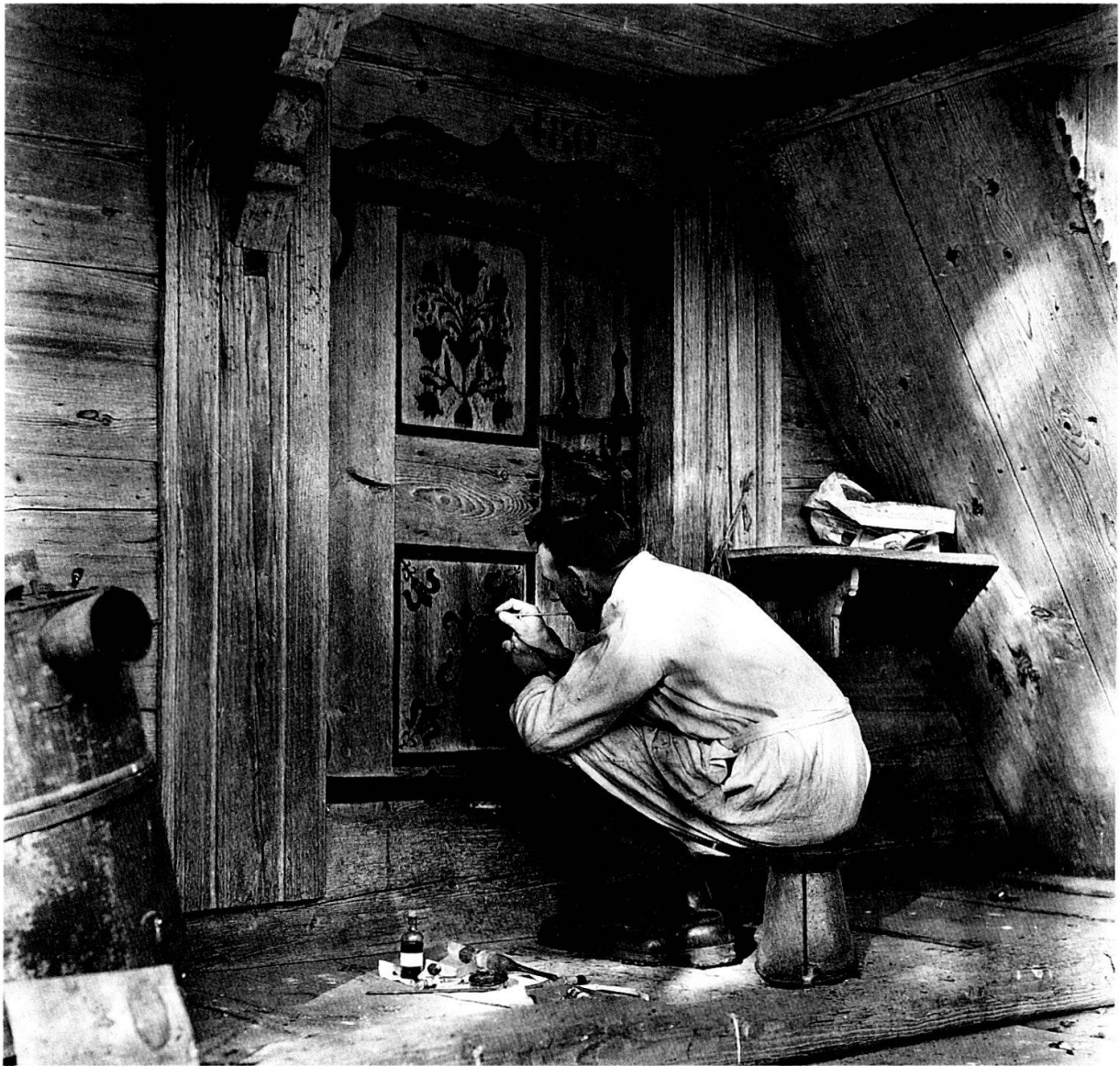
Christian Rubi bei einer seiner ersten eigenhändigen Malereirenovierungen an einem 1722 erbauten Speicher in Ried (Gemeinde Rüderswil, Nr. 480).
