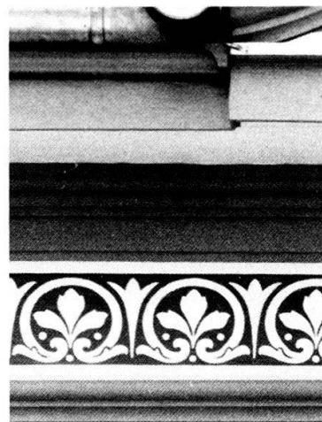
Malerweg 26: Rekonstruiertes lilienförmiges Dachkranzfries.
