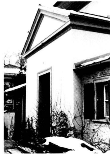
Schiferli-Gut: Der klassizistische Portikus vor dem Abbruch.
