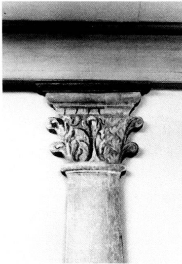
Nägeli-Haus: Kapitell des Brettpilastertäfers im Hofzimmer des 1. Obergeschosses, rechts die Fassung anfangs 18. Jh., links die um einige Jahrzehnte jüngere Übermalung.
