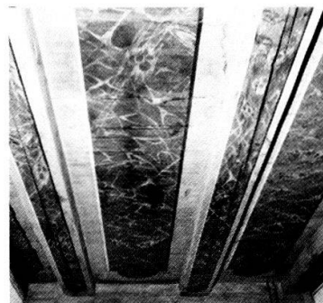
Ausschnitt der bemalten Balkendecke des späten 17. Jahrhunderts an der Brunngasse 10.
