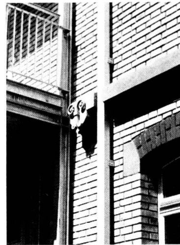
Ehemaliges Magazingebäude: Anschluss der neuen Laubengang-Konstruktion an die bestehende Fassade.
