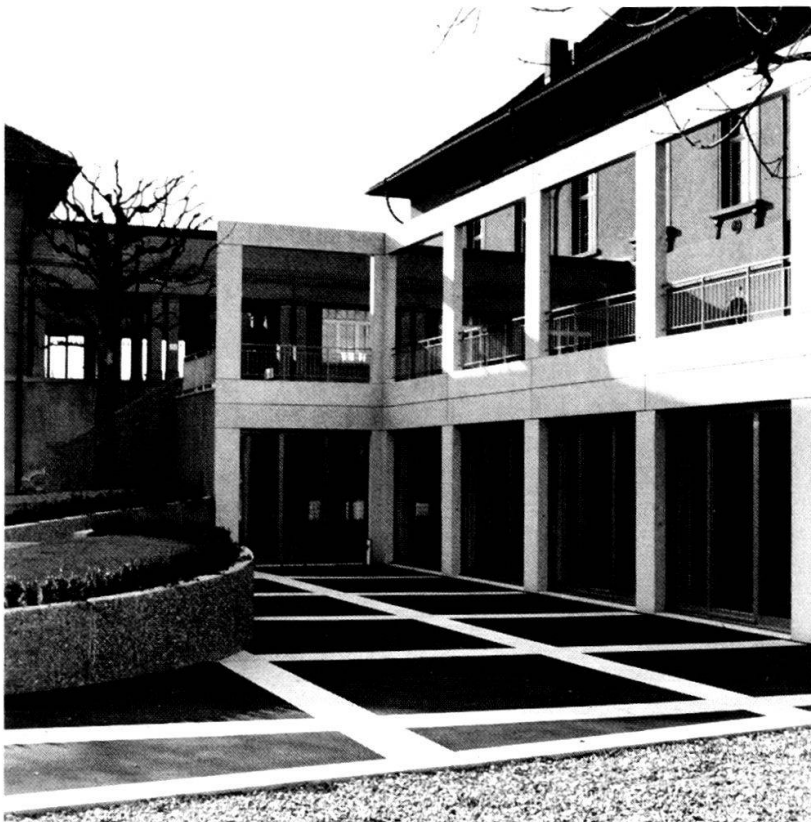
Friedenskirche: Fassade des neuen Gemeindesaales zwischen Westfassade und ehemaliger Gartenanlage.
