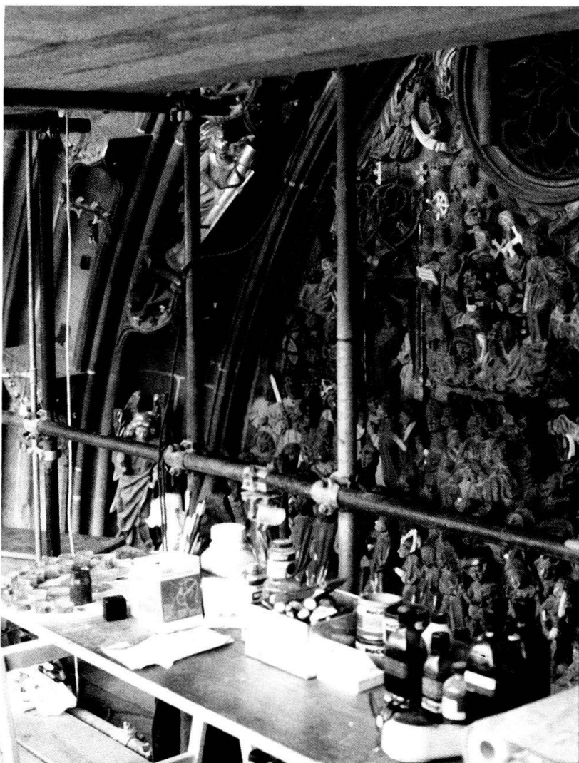
Das «Restaurierungsatelier» in der mittleren Vorhalle des Berner Münsters; die Kopien der Gewändefiguren bereits versetzt, das Tympanon nach Reinigung und Form-Ergänzungen.
