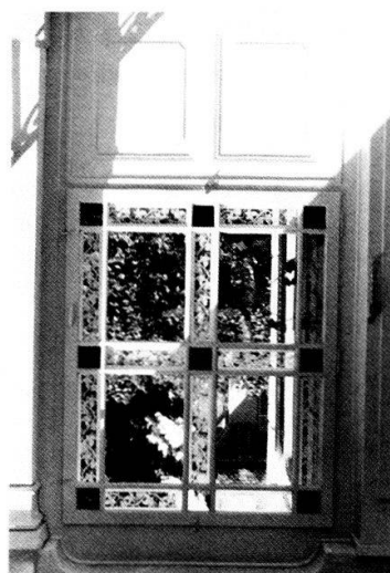
Altenbergstrasse 120: Der sorgfältigen Detailpflege wurde Aufmerksamkeit geschenkt.
