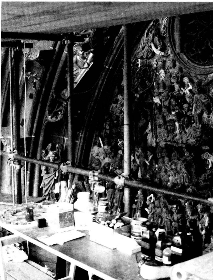
Das «Restaurierungsatelier» in der mittleren Vorhalle des Berner Münsters; die Kopien der Gewandfiguren bereits versetzt, das Tympanon nach Reinigung und Form-Ergänzungen.
