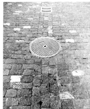
Münstergasse: Detail der Pflasterung von 1990.
