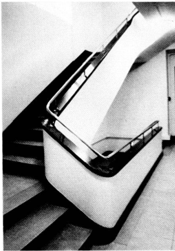
Marktgasse 53: Treppenhaus der Bauzeit im Modehaus Ciolina.
