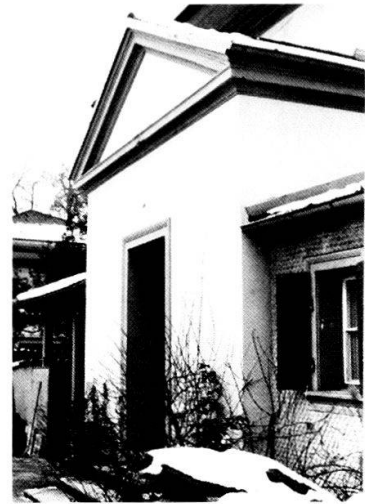
Schiferli-Gut: Der klassizistische Portikus vor dem Abbruch.
