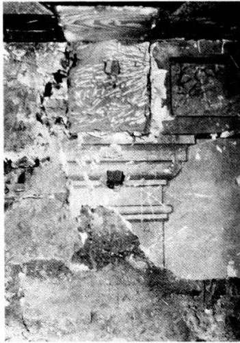
Marktgasse 55: Fragment einer architekturbetonenden Dekorationsmalerei in einem Hofzimmer des westlichen Hausteils.
