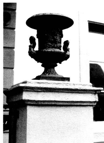
Gusseiserne Schale am Mey-Haus aus der Bauzeit.
