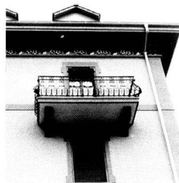
Berchtoldstrasse 11–15: Detail der renovierten Fassade mit Dachkranz-Fries und Balkongitter.
