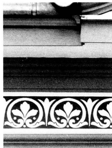
Malerweg 26: Rekonstruiertes lilienförmiges Dachkranzfries.
