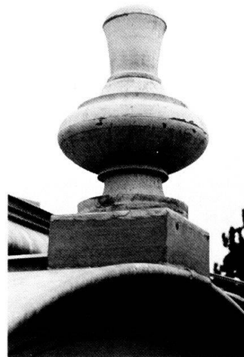
Beaulieustrasse 72: Restaurierte Dachvase auf Mansart-Dach.
