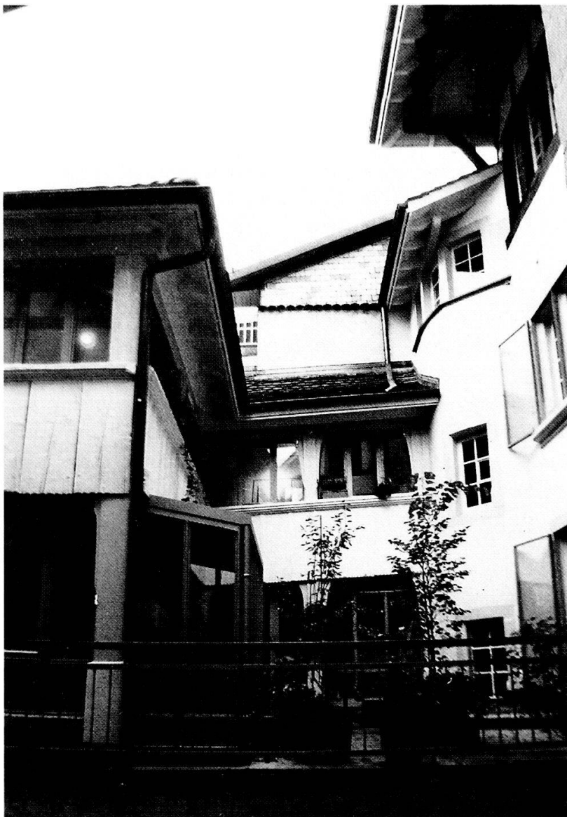
Innenhof des Hauses Münster- gasse 30 mit neu befenstertem Hofgebäude, aufgestocktem Treppenturm und Rückfassade des Hauptgebäudes mit Auf- zugsgebel.
