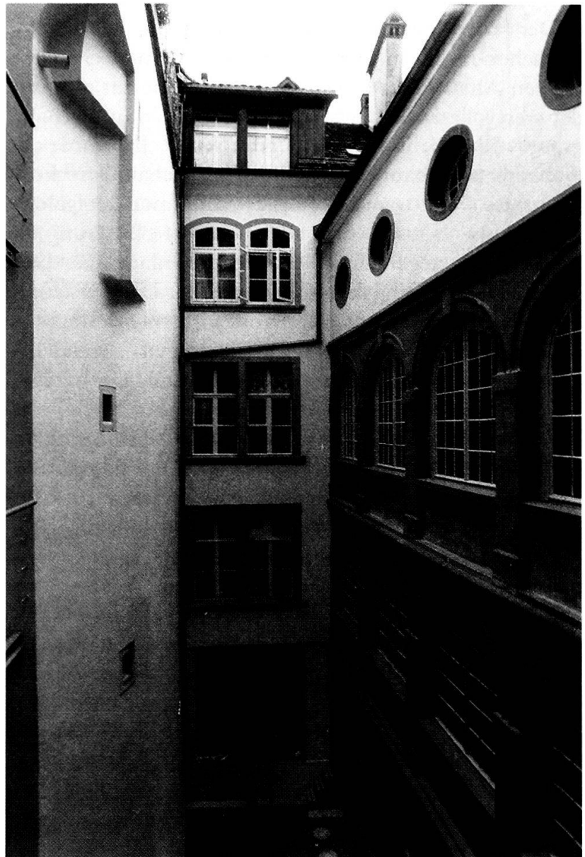
Rathausplatz 1: Der bis in das Erdgeschoss freigelegte Innenhof mit der um das fehlende Joch ergänzten und auf die ursprüngliche Höhe reduzierten Hofgalerie (rechts).
