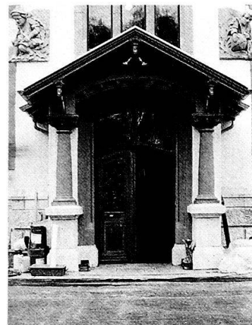
Portalvorbau des Oberseminar-Gebäudes.
