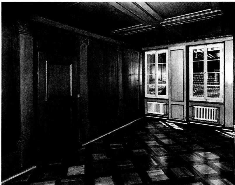
Brunngasse 52: Zimmerausstattung um 1780 mit Brett-Pilaster-Täfer und flacher Felderdecke, Zustand nach Restaurierung.
