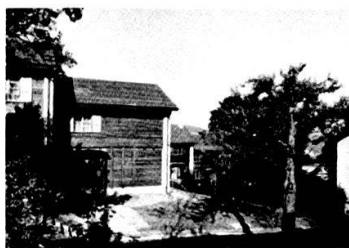
Siedlung Hohliebi: Ostansicht einer Häusergruppe, Zustand 1985.
