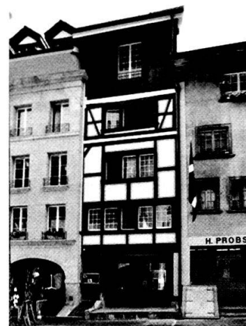
Münstergasse 57: Gassenfassade nach Restaurierung 1982/83.
