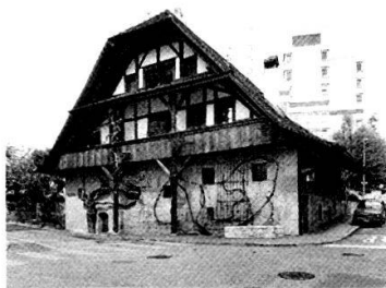
Brunnenhaus: Ansicht von Süden, Zustand 1985.
