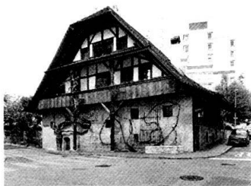
Brunnenhaus: Ansicht von Süden, Zustand 1985.
