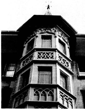
Erker des Mayhauses: zweites und drittes, 1895 aufgesetztes Geschoss, nach der Rekonstruktion 1985.
