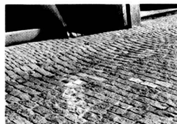
Postgasse: neue Pflasterung von 1981/82.
