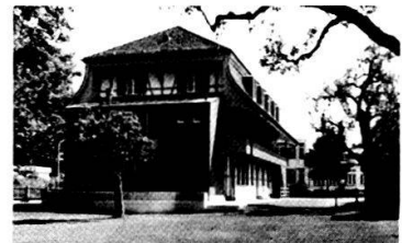
Stock des alten Dorfschulhauses Bümpliz: Ansicht der Rückseite mit Anbau von 1979/80.
