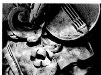
Stadttheater: Requisitenrelief vor der Sanierung sowie nach Reinigung, «Nachzeichnung» und Verfestigung.
