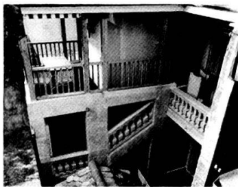
Gesellschaftshaus zu Kaufleuten: das freigelegte Treppenhaus von 1718–22 und der Holzaufbau von 1981.
