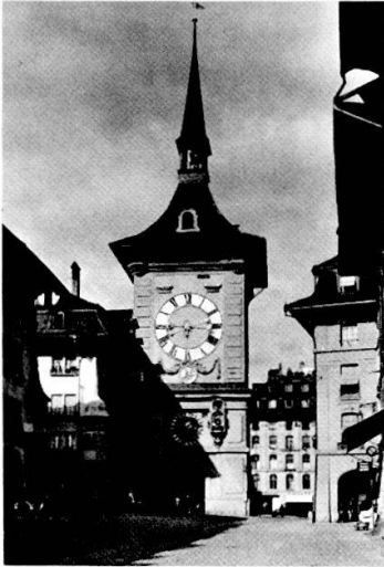
Zytglogge: Zustand vor der Restaurierung, Aufnahme um 1940.
