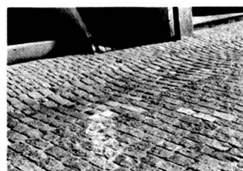
Postgasse: neue Pflasterung von 1981/82.
